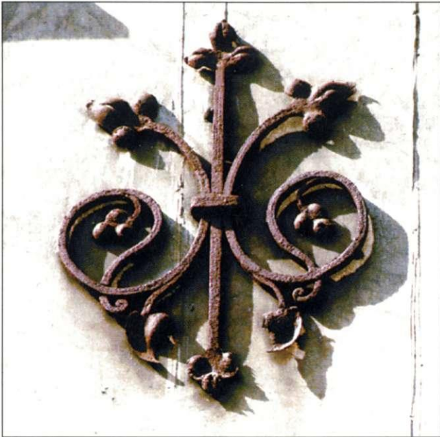
Abb. 42 Schmiedeeiserner Zieranker an der Fassade Gerhart-Hauptmann-Straße 64
