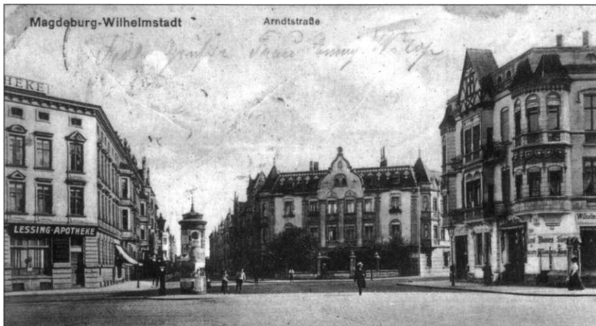
Abb. 2 Kreuzung dreier Straßen, Blick in Südrichtung; hinter der Litfaßsäule verläuft die Arndtstraße, rechts hinten liegt die Einfahrt in die Lessingstraße, vorne rechts zweigt die Wilhelm-Külz-Straße ab; Postkarte gestempelt 1918
