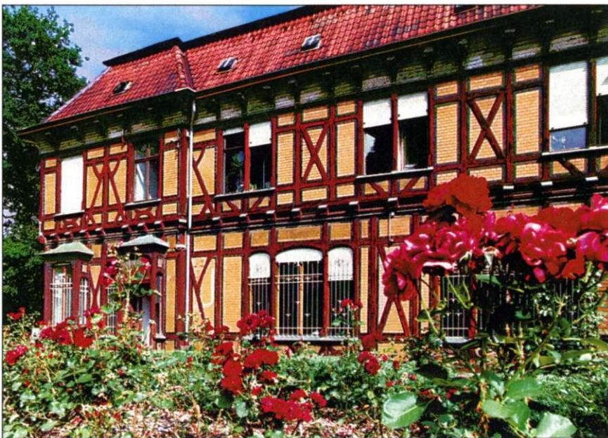
Abb. 21 Liebknechtstraße 14, Blick von der Straße
