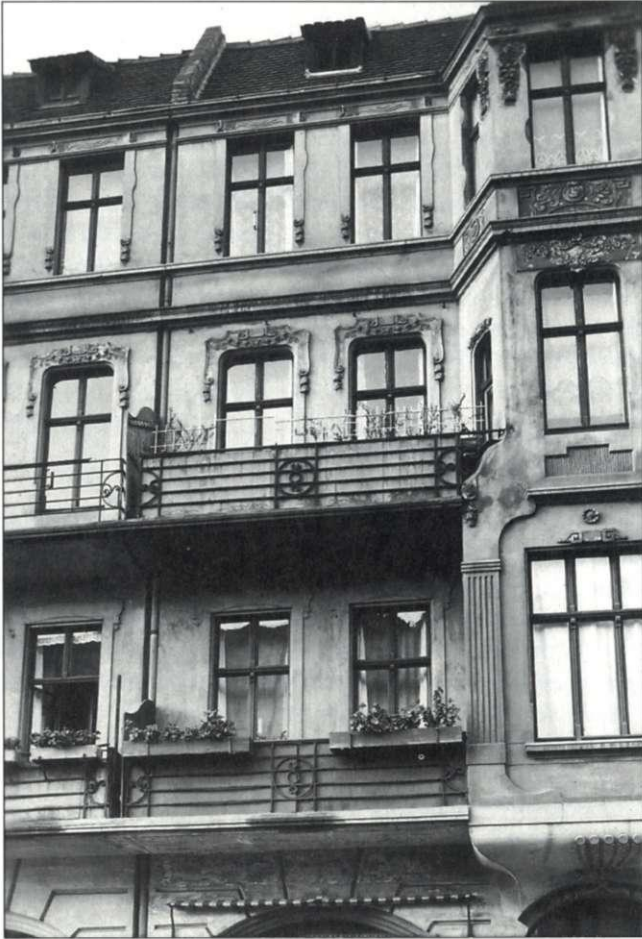
Abb. 75 Westring 8, Detail, Aufnahme vom 13.11.1935
