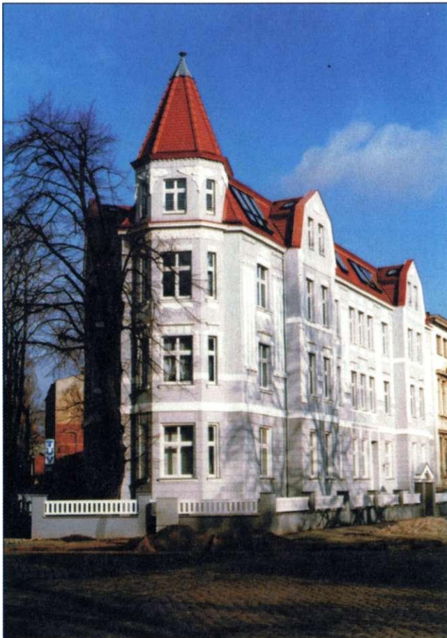
Abb. 79 Adelheidring 17, Blick von der Straßenkreuzung auf das Gebäude
