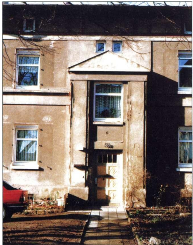
Abb. 99 Ursprüngliche Behelfswohnungen, Eingang Haus-Nr. 40
