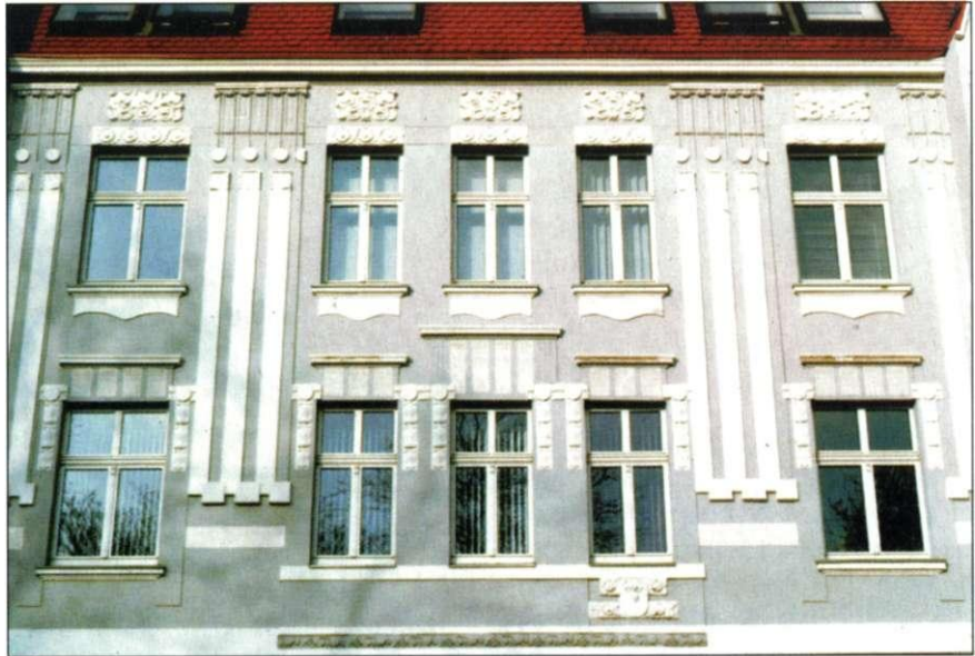
Abb. 81 Adelheidring 17, Detail der Fassade am Adelheidring
