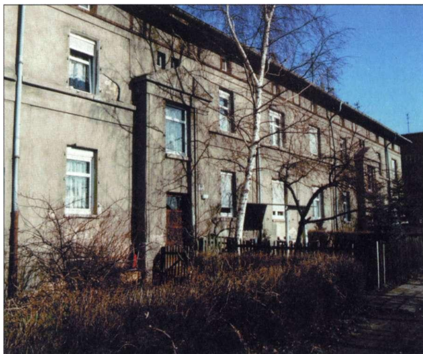
Abb. 101 Ursprüngliche Behelfswohnungen, Häuser Nr. 46 und 46 a
