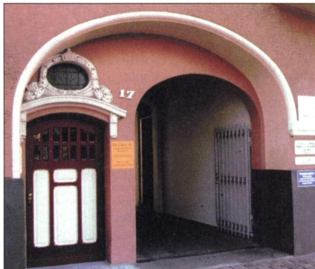
Abb. 126 Westring 17, Eingang und Durchfahrt von einem Bogen überfangen, 1909
