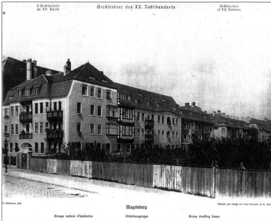
Abb. 85 Wilhelm-Külz-Straße 10 und Hans-Löscher-Straße 28, Aufnahme nach der Fertigstellung
