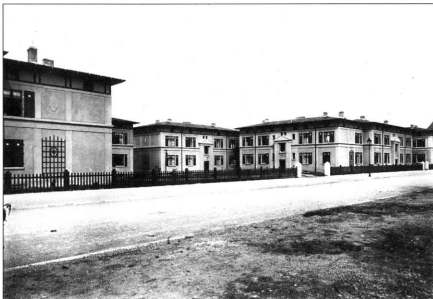
Abb. 97 Fertiggestellte Behelfswohnungen, Ansicht von Südosten
