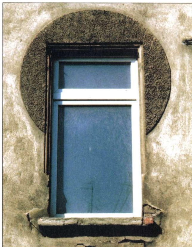
Abb. 110 Winkelmannstraße 29, schmale Profilierung der Fensterlaibung und Fensterschmuck aus Rauhputz
