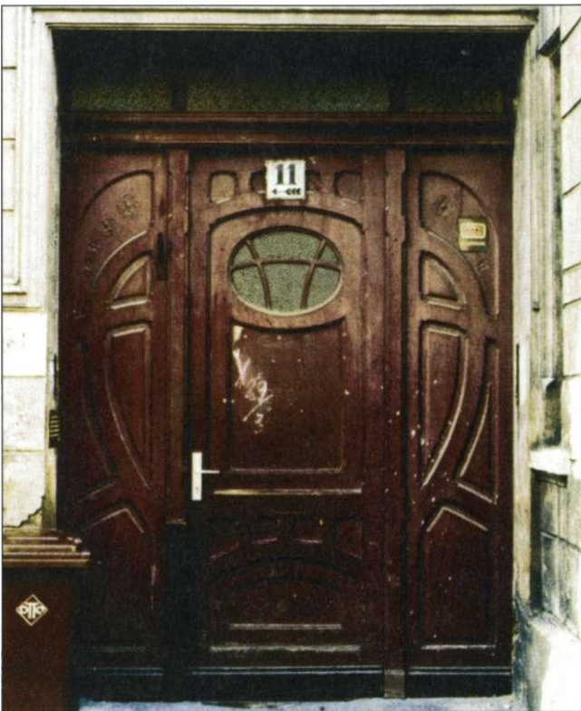
Abb. 123 1906, Einfahrtstor Winkelmannstraße 11, die seitlichen Paneele können bei Bedarf geöffnet werden
