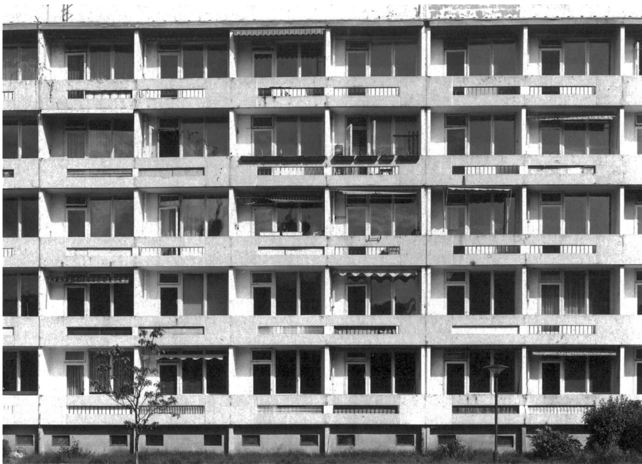
Abb. 9 Architektur des Appartementhauses am Domplatz, Baujahr 1966 (Zustand 1997)
