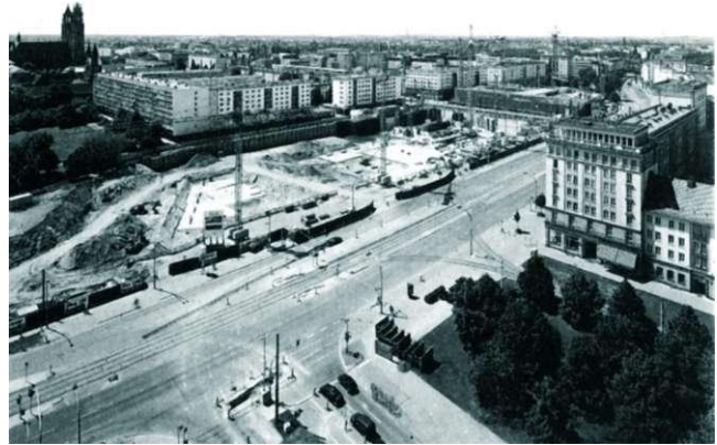
Abb. 3 Baugeschehen am Zentralen Platz, 1997
