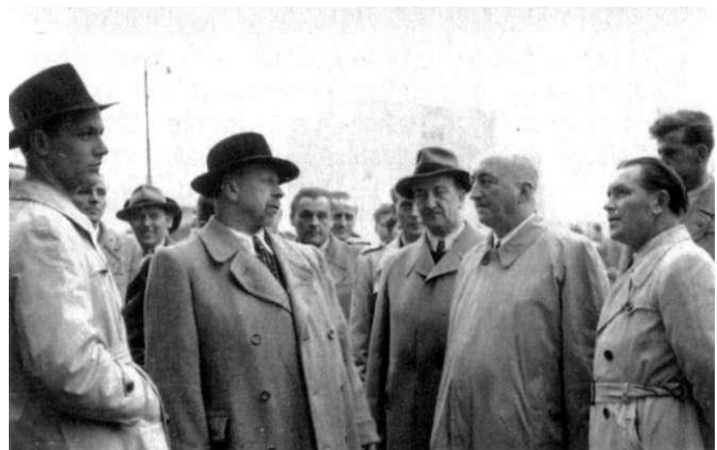
Abb. 47 Besuch von Walter Ulbricht auf der Baustelle am Zentralen Platz mit (v.l.n.r.) H. Heinemann (Stellv. Chefarchitekt), W. Ulbricht, Ph. Daub (Oberbürgermeister der Stadt Magdeburg), J. Kramer (Chefarchitekt) und Bötsche (Stadtbaudirektor), 1953
