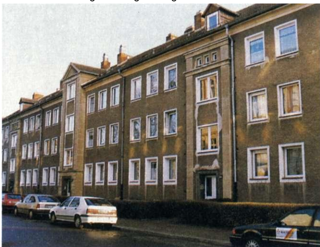
Abb. 72: Bebauung am Langer Weg
