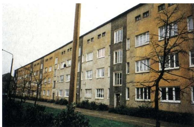
Abb. 40: Reparaturabschnitt am Wohnpark Rothenseer Straße in der Curie-Siedlung
