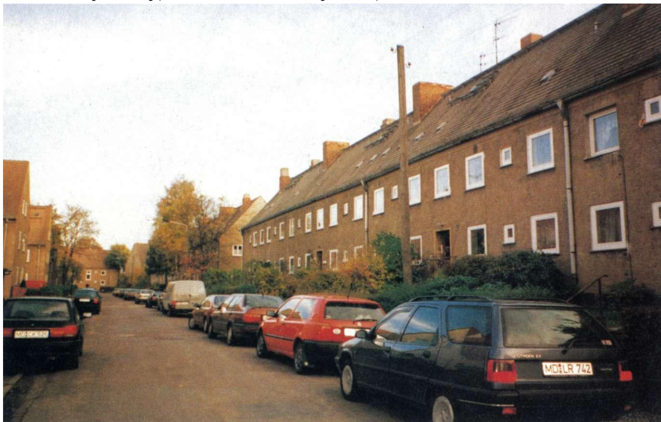
Abb. 52: Bebauung Marderweg (ehem. Trautenauer Straße, heutiger Zustand)
