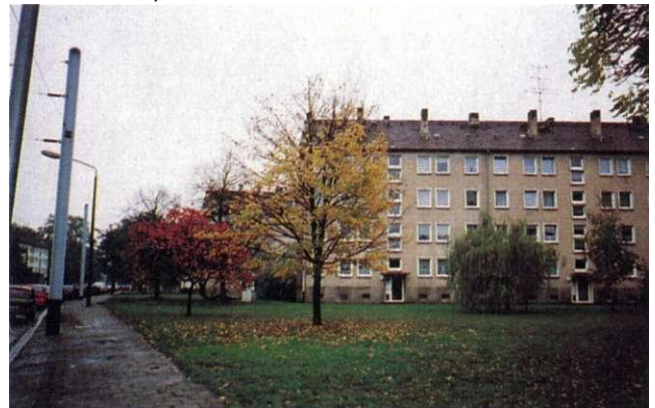
Abb. 58: Hoheforte Straße Nordabschnitt
