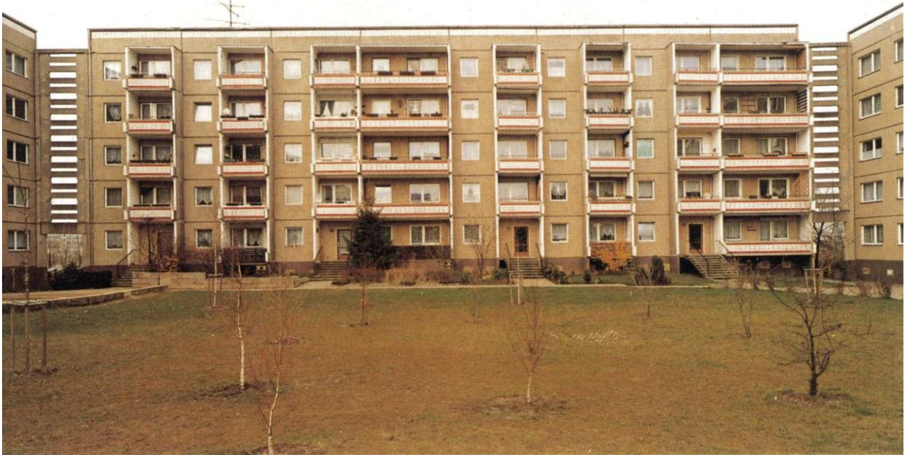
Abb. 166: Hans-Grade-Straße (Olvenstedt, 1. Bauabschnitt)
