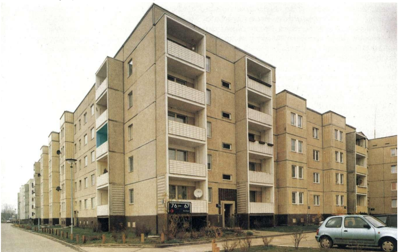
Abb. 169: Rennebogen (Olvenstedt, 5. Bauabschnitt)
