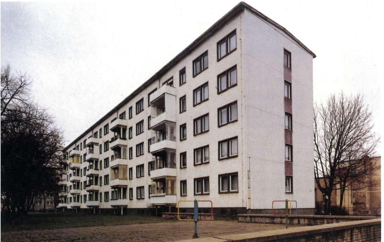
Abb. 149: Peterstraße (Wohnkomplex Jakobstraße)
