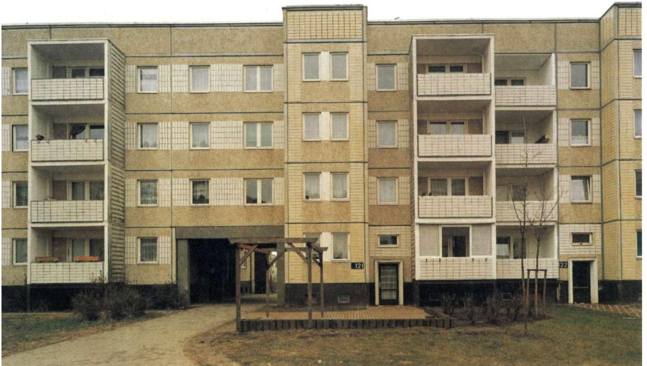
Abb. 168: Rennebogen (Olvenstedt, 5. Bauabschnitt)
