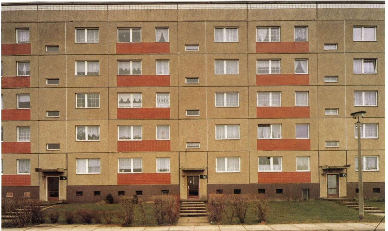
Abb. 167: Hans-Grade-Straße (Olvenstedt, 1. Bauabschnitt)
