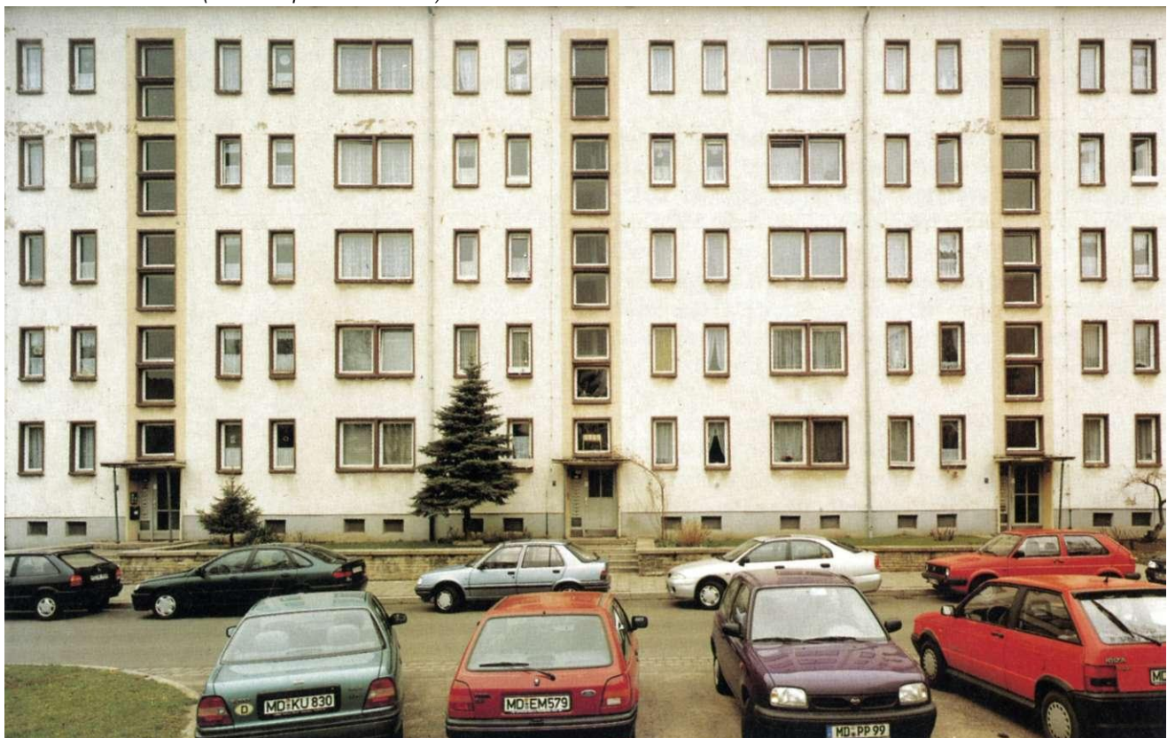
Abb. 150: Peterstraße (Wohnkomplex Jakobstraße)
