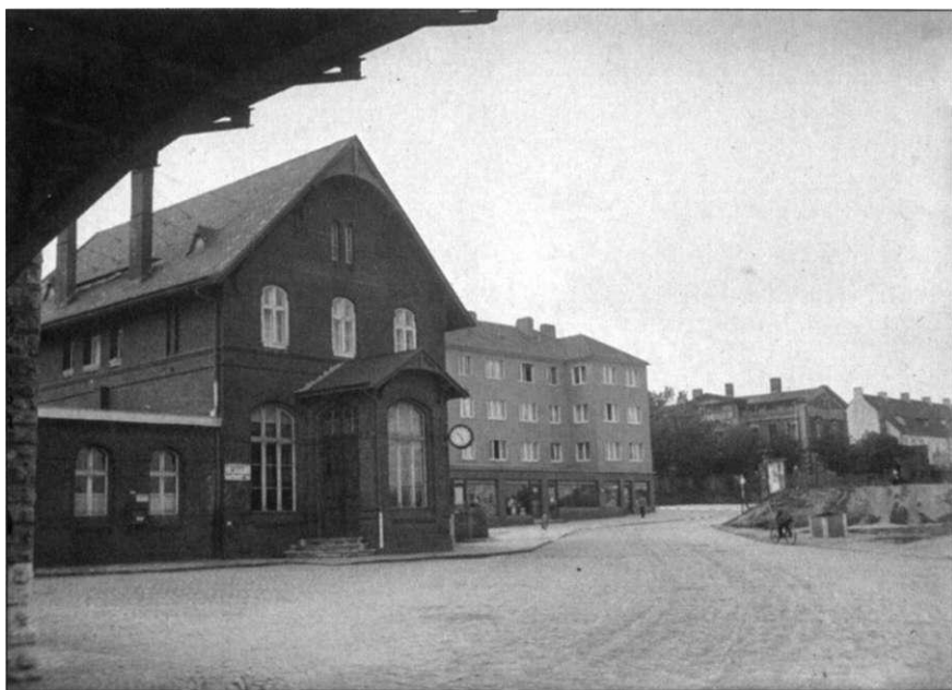
25 Am Bahnhof Südost
