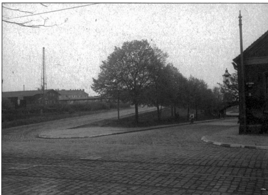
24 Einmündung Welsleber Straße zum Bahnhof Südost (30er Jahre)
