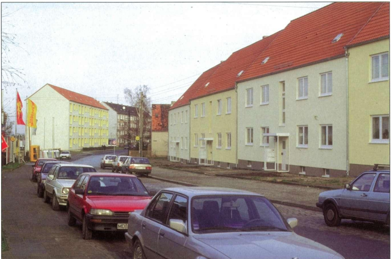
7 Sanierung der Geschößwohnungen an der Welsleber Straße durch die Wohnungsbaugenossenschaft Südost (Dezember 1994)
