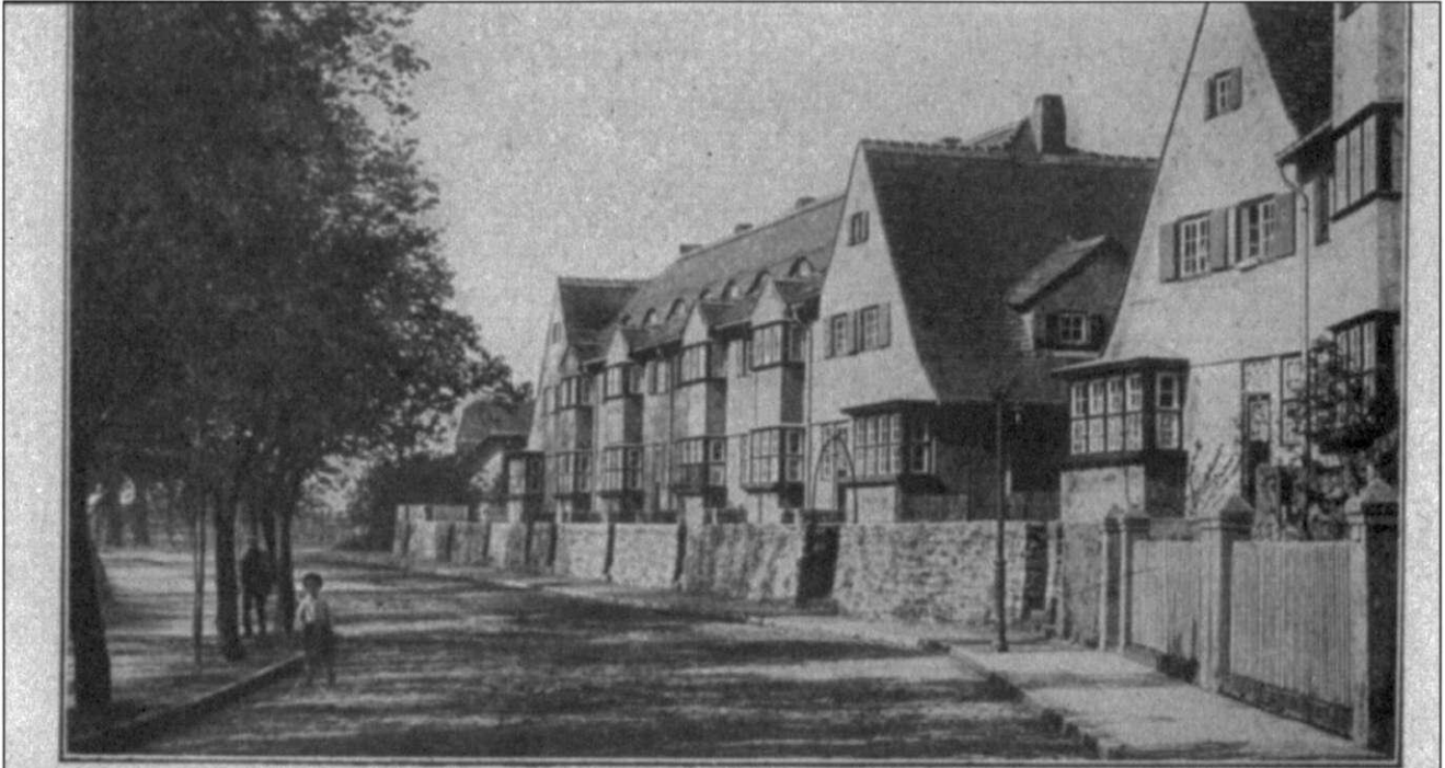
Abb. 113 Städtische Wohnhäuser am hinteren Gotthardsteich Merseburg, „System Zollbau“ Architekt: Stadtbaurat Zollinger, Merseburg
