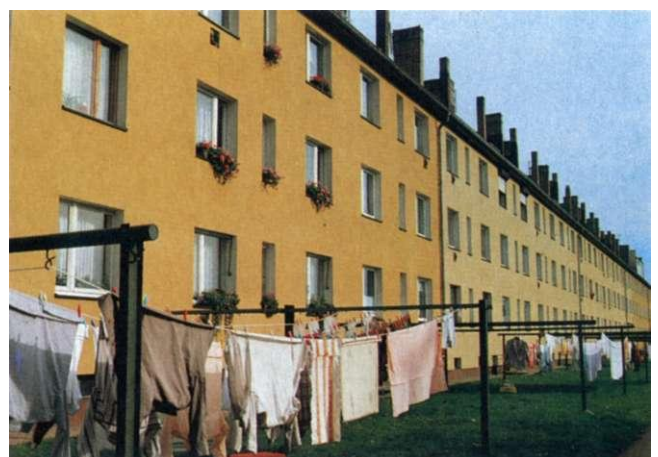
Abb. 110: Eickendorfer Straße Nr. 1-15, Hofansicht zum Steinlagerplatz, 1994 saniert
