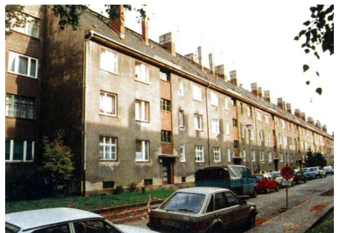
Abb. 101: Mühlinger Straße Nr. 2-16, gen Süden
