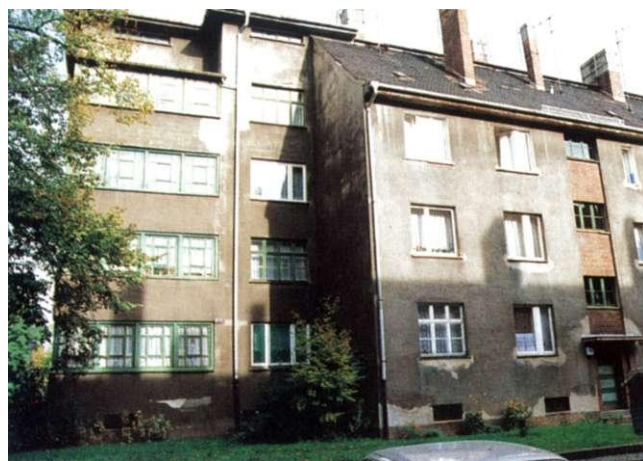
Abb. 102: Mühlinger Straße Nr. 16, Platzbildung zur Straße Am Fort
