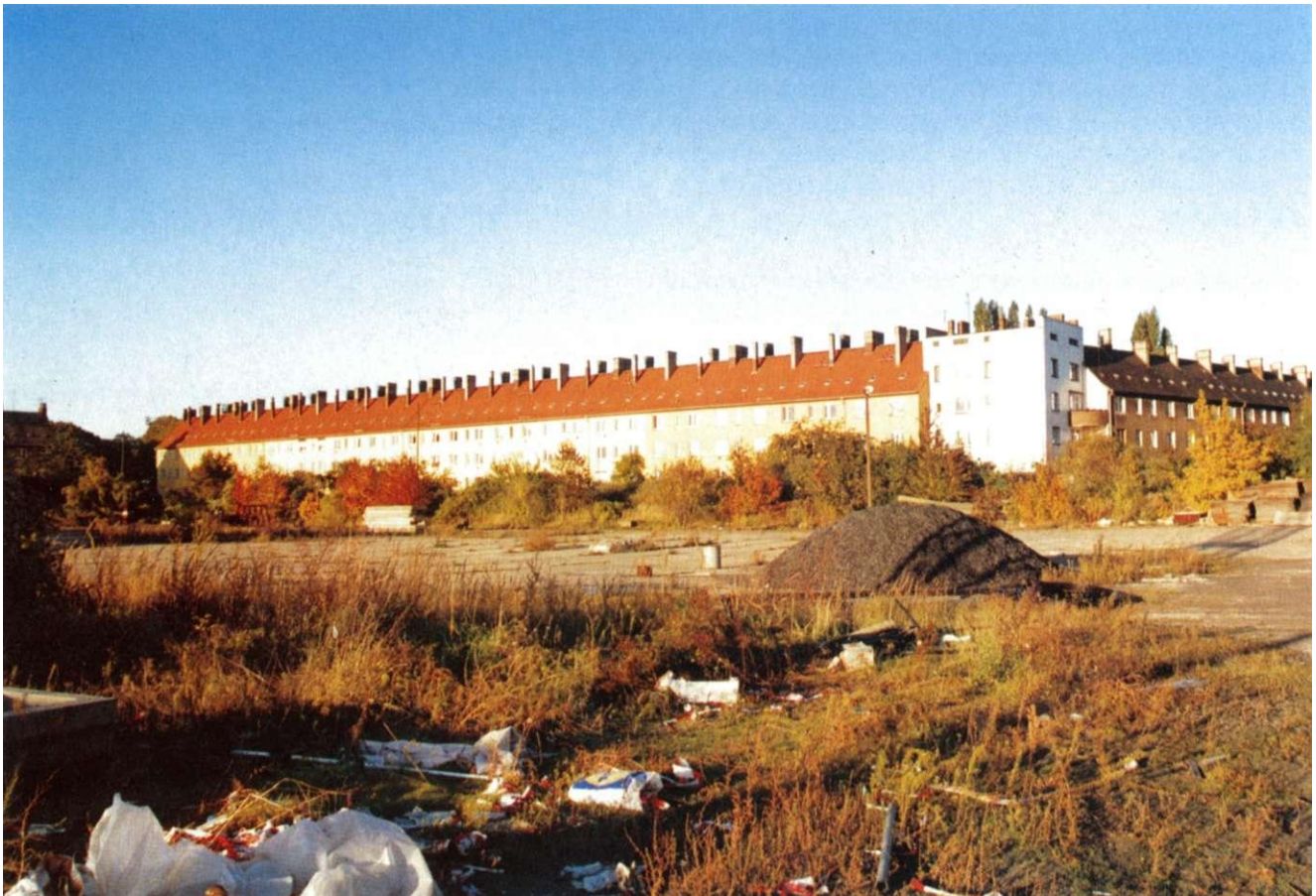
Abb. 111: Ansicht der sanierten Hoffassade Eickendorfer Straße 1-15 vom Steinlagerplatz aus gesehen
