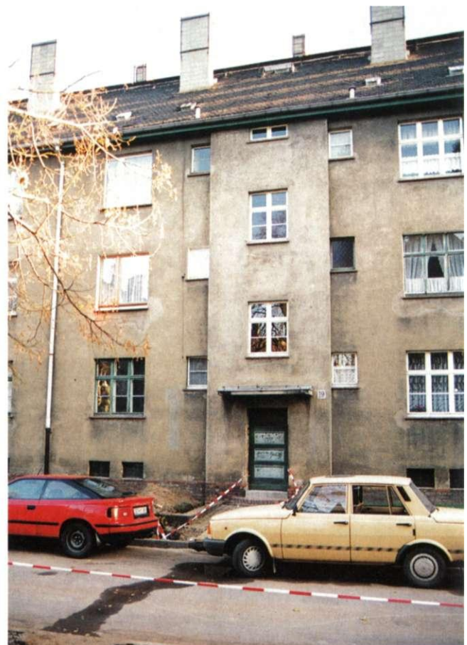
Abb. 125: Zinckestraße Nr. 19, Architekt Wahlmann
