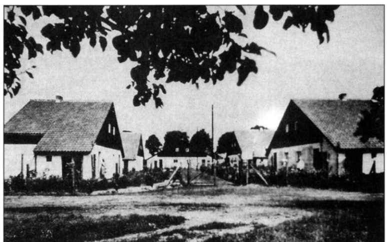
Stadtrandsiedlung Falkenberg bei Berlin; Lageplan der Siedlung, Ansicht eines Doppelhauses und Gebäudegruppe.
