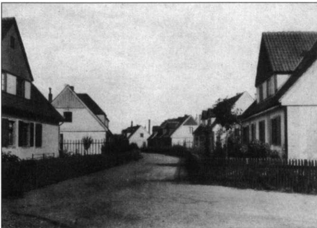
Blick vom Sonnensteg in den Sichelweg, 1930. Die Gebäude mit den doppelten Dachgauben im Hintergrund entsprechen dem Typ der Entwurfszeichnungen von 1921 auf Seite 42.
