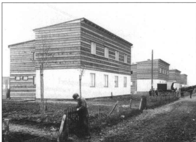
Jetzt sind auch die Vorgärten und die Zufahrten (Gartenwege) gerichtet, die Birken in den Vorgärten gepflanzt (1. Bauabschnitt). (Quelle: Stadtarchiv Magdeburg)
