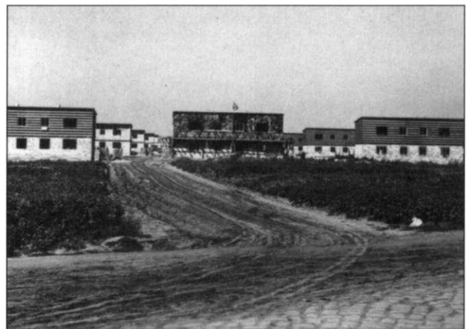
Der letzte Bauabschnitt von Osten gesehen. Zwischen die Häuser führt eine Baustraße. (Quelle: Stadtarchiv Magdeburg)
