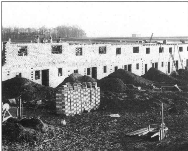
Aufnahme der Westzeile von Nordwesten. Erkennbar ist die Massivbauweise der Häuser auch im Obergeschoß. Die angebauten eingeschossigen Nebengebäude fehlen hier noch. (Quelle: Stadtarchiv Magdeburg)
