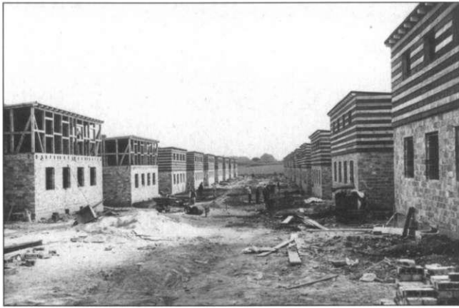
Bauphase. Blick nach Süden: die Fachwerkkonstruktion der Obergeschosse steht, die Verbreiterung (Stülpchalung) in dem charakteristischen „Zebra-Muster“ ist fast überall angebracht. (Quelle: Stadtarchiv Magdeburg)
