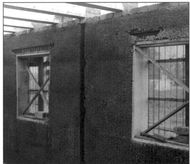
Ein bauliches Experiment: die Wände wurden teilweise in Schüttbeton errichtet (Quelle: Stadtarchiv Magdeburg)
