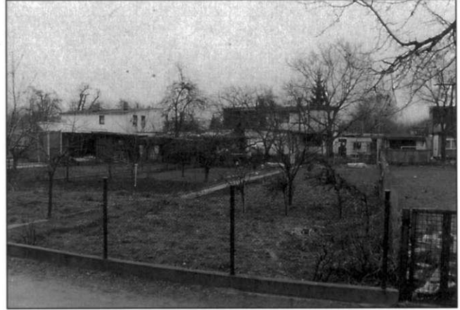
Birkenweiler: die große Tiefe der Grundstücke läßt eine zweiseitige Bebauung der Gartenwege zu.
