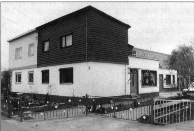
Birkenweiler: der ursprüngliche Winkelbau ist noch erkennbar, Anbauten erstrecken sich tief in den Garten hinein.
