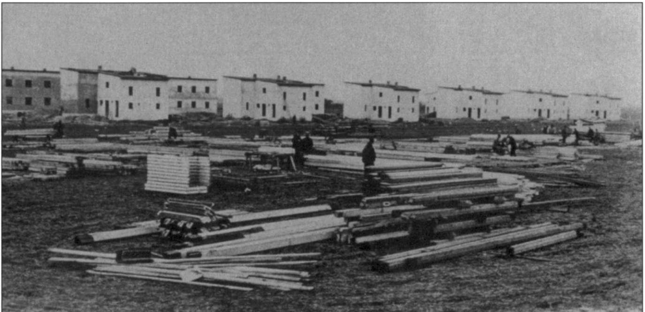
Der große Richtplatz für die Zimmererarbeiten. Auch das Bauholz stammte zum großen Teil aus Abbruchhäusern. (Quelle: Archiv der Siedlergemeinschaft Lindenweiler)
