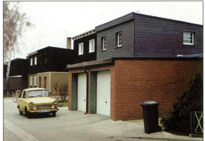
Gestalterisch unakzeptabel, aber ökologisch weniger bedenklich: Doppelgarage im Vorgarten. Ein Beispiel aus Kreuzbreite.
