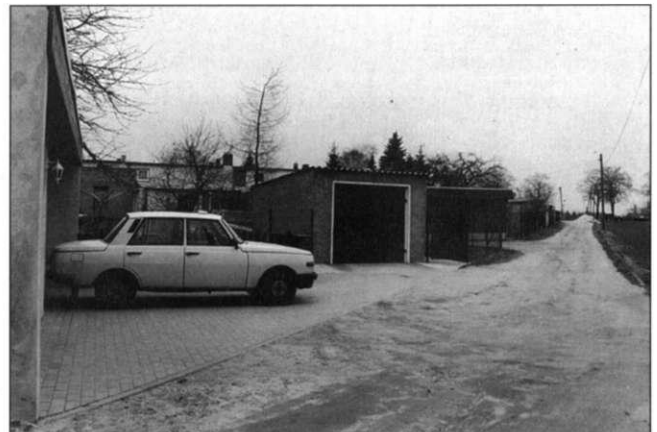
Eine fast durchgängige Garagenreihe an der Gartenrückseite der Siedlung Eulegraben. Nicht überall ist der Vorplatz gegen Treibstoff und Öl gesichert.
