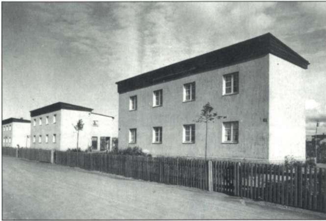
Häuser und Straße sind fertig, die Hausbäume (Linden) sind gepflanzt. (Quelle: Stadtarchiv Magdeburg)
