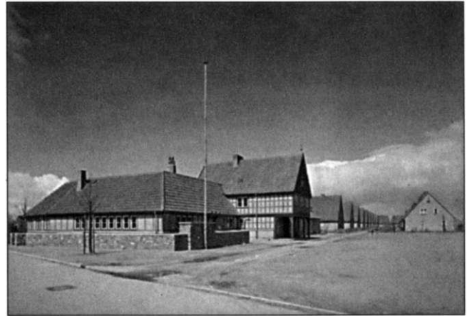
Vorlaubenhaus nach der Fertigstellung
