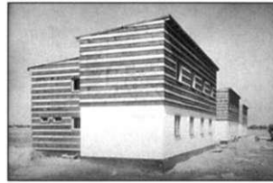
Gebäude am Milchweg im Rohbau, 1932
