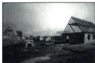
SA-Dankopfersiedlung im Bau
