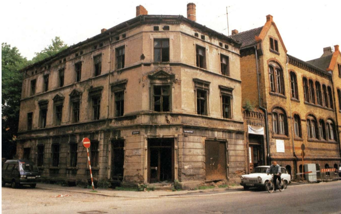
Bild 3: leerstehendes, bestandsgefährdetes Gebäude (Karl-Schmidt-Str. 59) ▼
