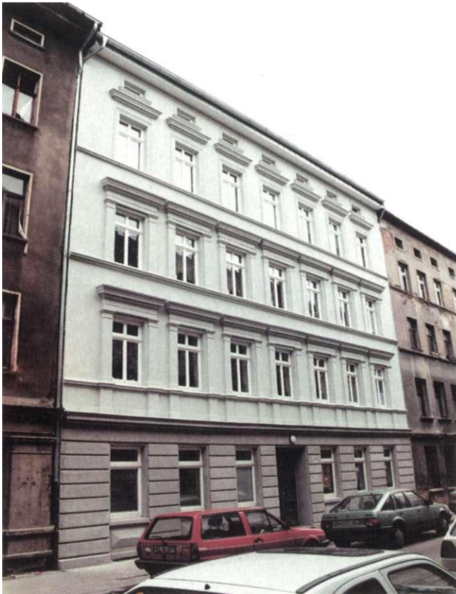
Bild 415: Klosterbergstraße 25 vor und nach der Sanierung
