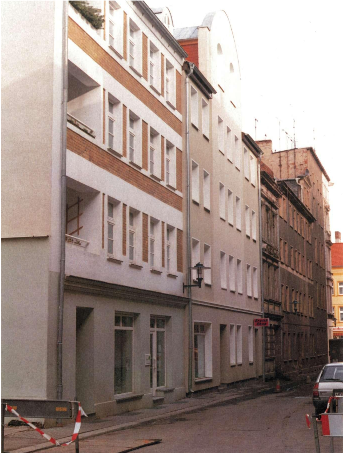
Bild 31: Zwei sanierte Häuser in der Bernburger Straße
