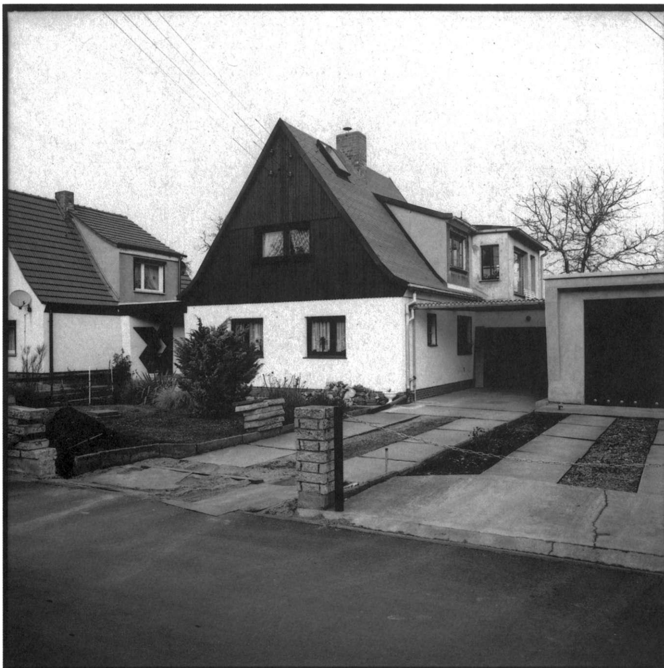
Aufstockung über dem ehemaligen Stallgebäude.
