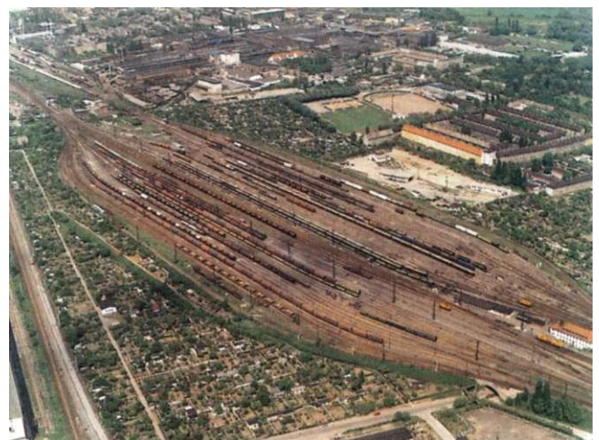
Abb. 46b: Schrägluftbild Rangierbahnhof Fermersleben (nach Nordosten)
