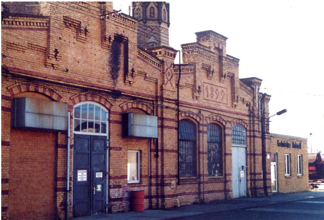
Abb. 69: Alt Salbke 11-13, Kesselhaus, Nordseite
