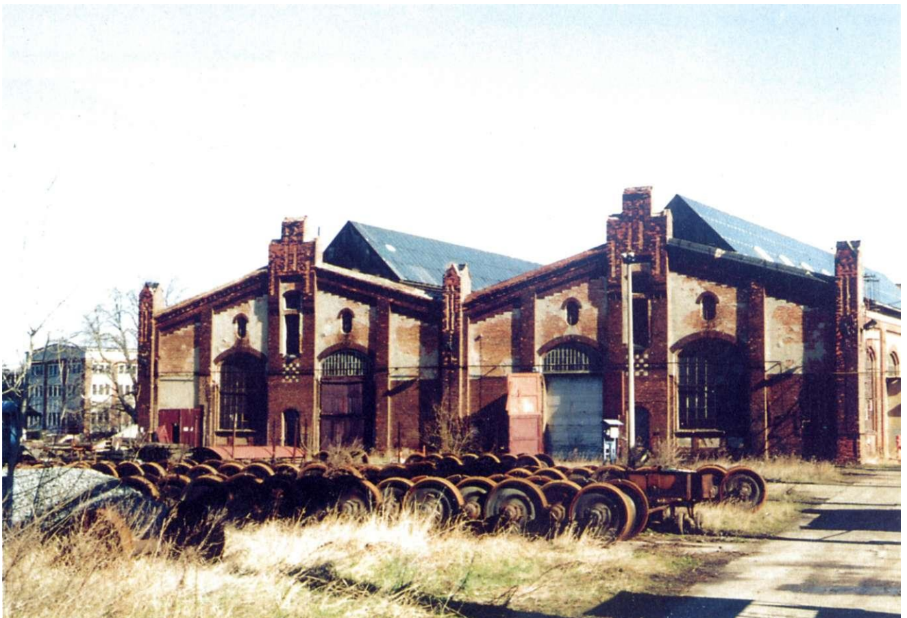
Abb. 70: Weichenbauanstalt Alt Salbke 11-13, Westseite
