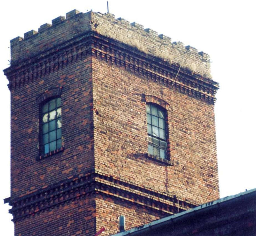
Abb 75: Blankenburger Straße 58-70, Wasserturm, Detail
