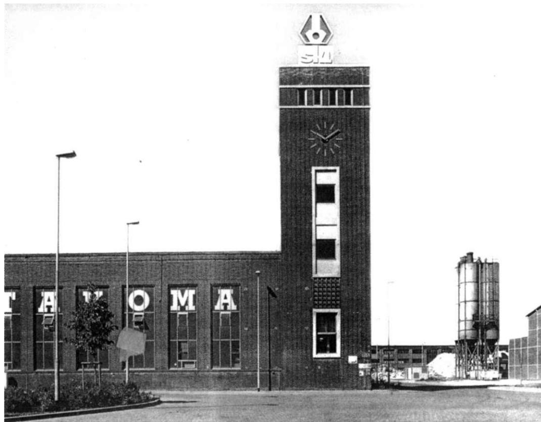
Abb. 62: Alt Salbke 6-10, Rohrschlängenbau, Ostseite
