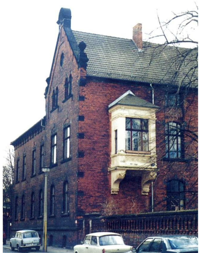
Abb. 84: Verwaltungsgebäude Coquistraße 16 c/d
