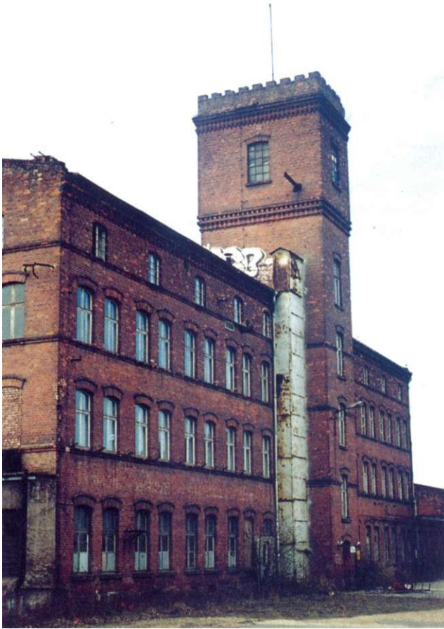
Abb. 74: Blankenburger Straße 58-70, Modellhaus mit Wasserturm
