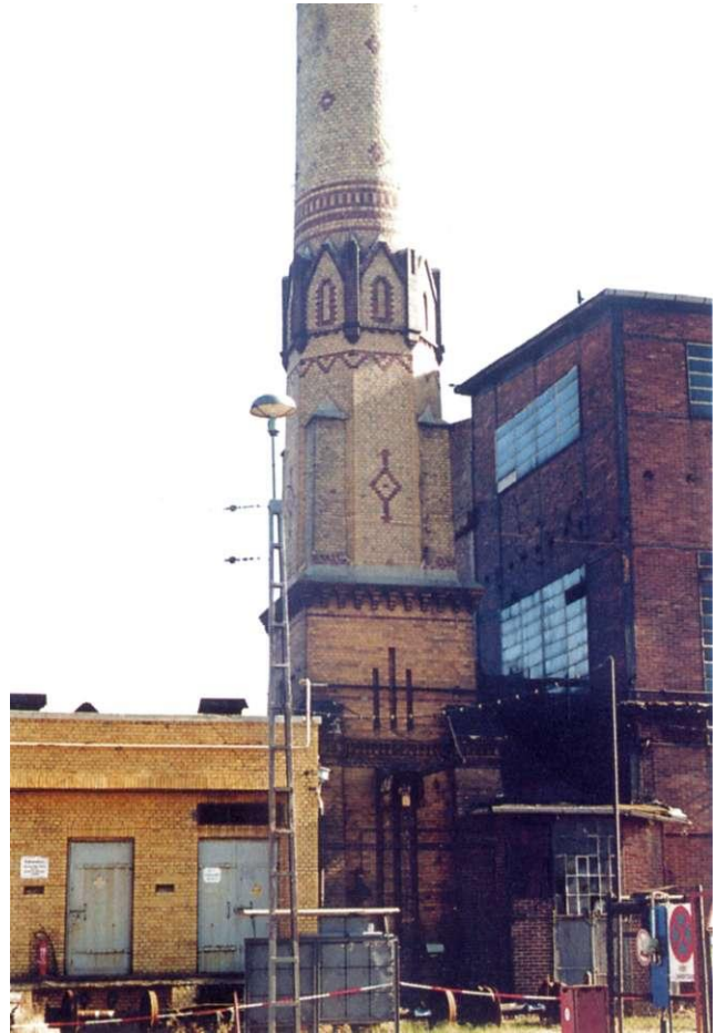
Abb. 68: Alt Salbke 11-13, Schornstein des Kesselhauses
