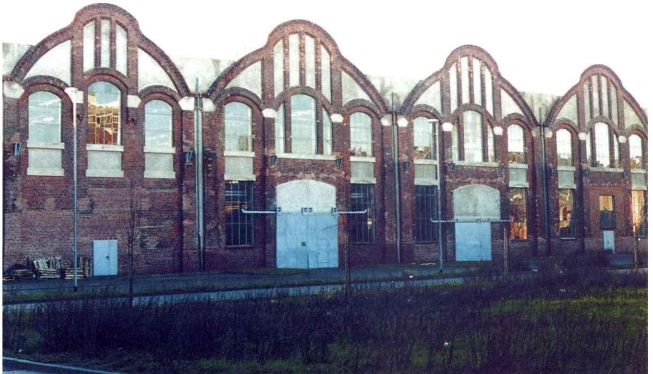
Abb. 60: Alt Salbke 6-10, Kesselschmiede, renovierte Ostfassade
