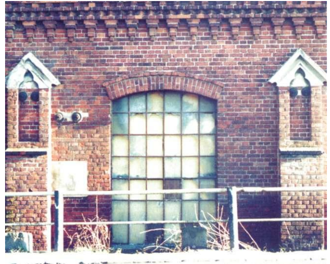
Abb. 71: Blankenburger Straße 58-70, Montagehalle, Detail des straßenseitigen Seitenschiffes
