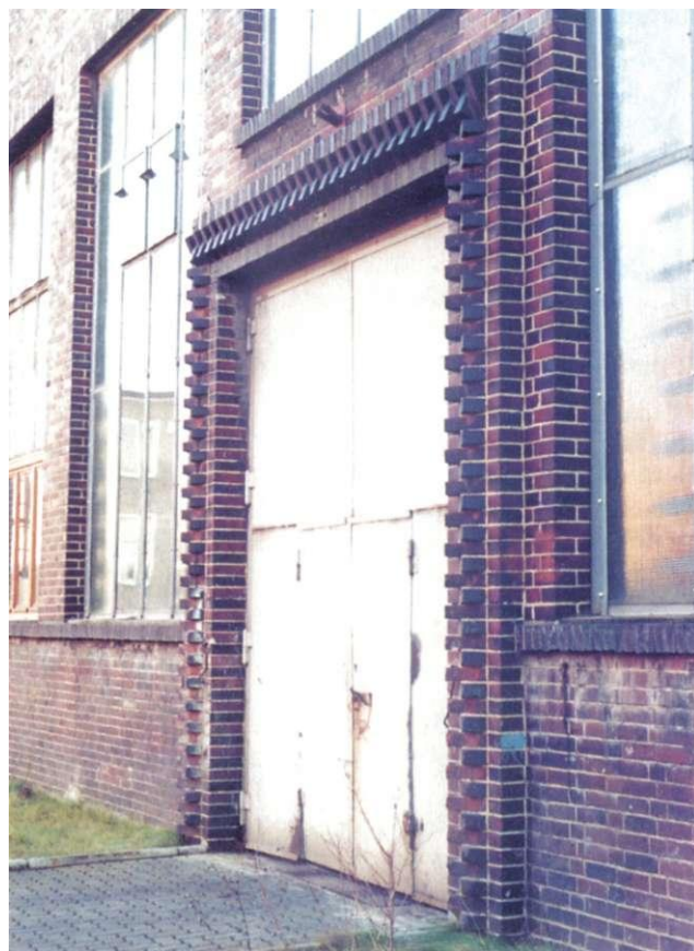
Abb. 63: Alt Salbke 6-10, Rohrschlängenbau, Tor auf der Nordseite
