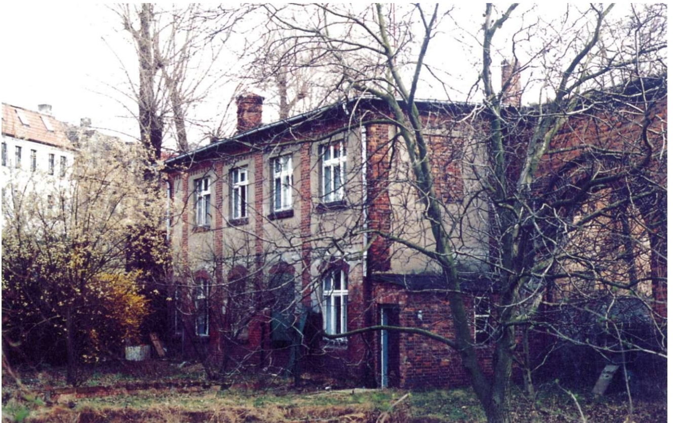
Abb. 82: Coquistraße 16 a, Dienstgebäude mit anschließender Torbogenwand
