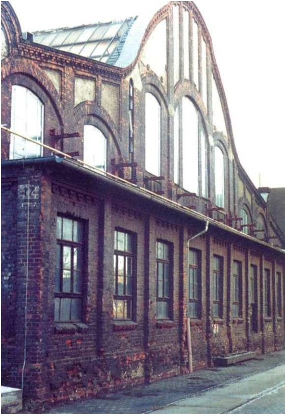
Abb. 57: Alt Salbke 6-10, Nordwand der Gießereihalle
