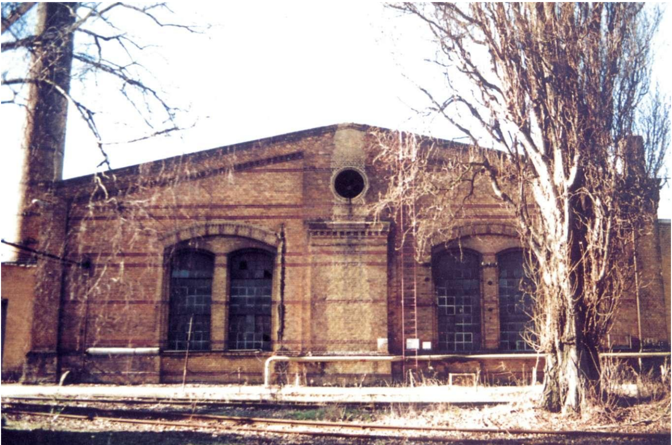
Abb. 66: Alt Salbke 11-13, östliche Giebelfront der Schmiede
