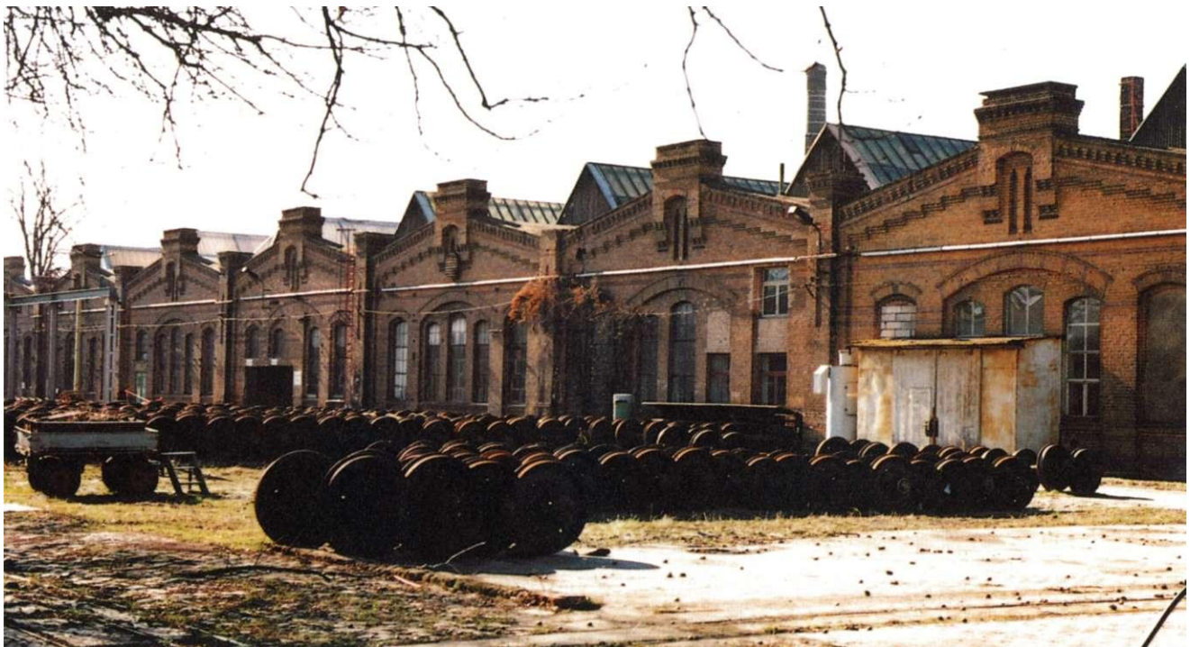
Abb. 64: Alt Salbke 11-13, Wagenreparaturwerkstatt
