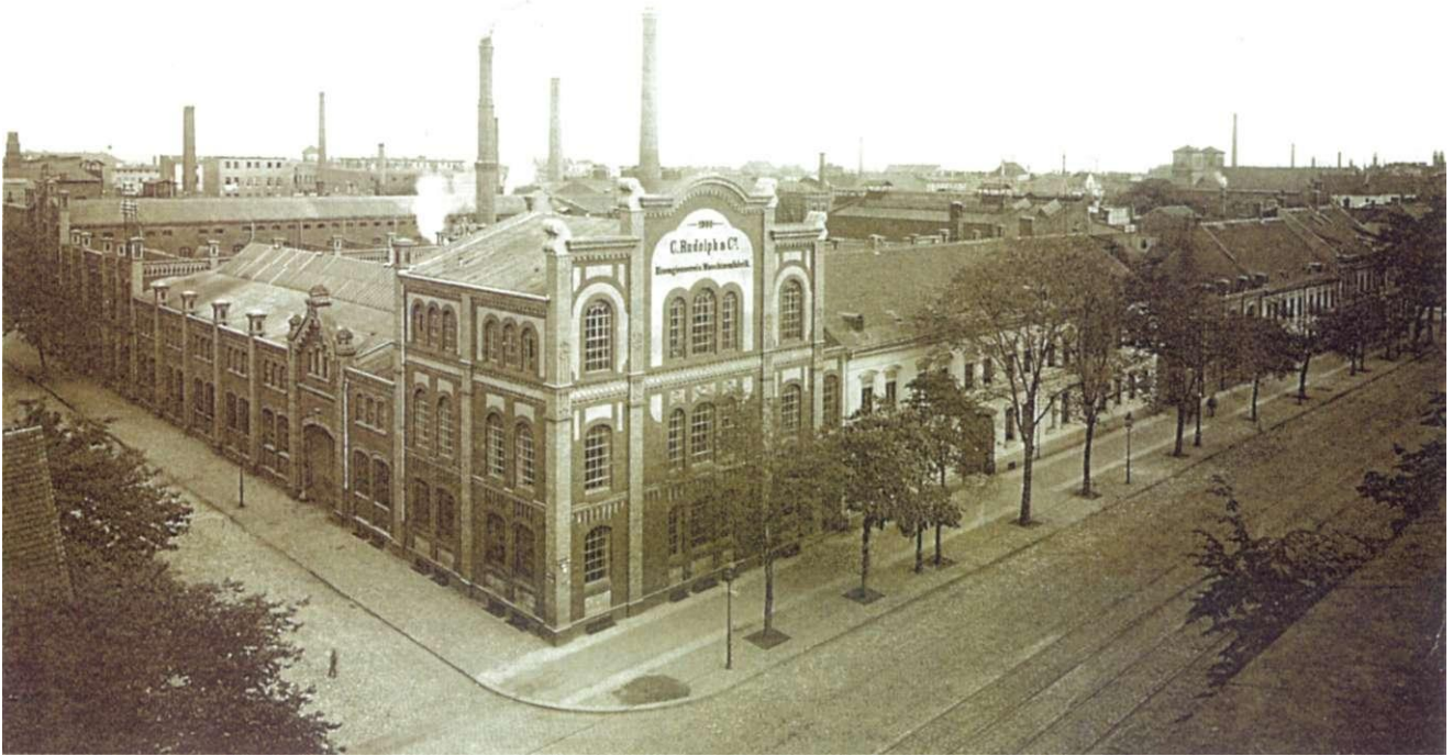
Abb. 36: C. Rudolph & Co., alte Aufnahme, Blick auf die Ecke Lübecker Straße und Fabrikenstraße, an der Straßenkreuzung das dreistöckige Lagerhaus aus dem Jahr 1900, rechts daneben das Wohnhaus und spätere Kontorgebäude aus dem Jahr 1852; an der Fabrikenstraße reihen sich nebeneinander von links Dreherei, alte Montagehalle und neue Montagehalle
