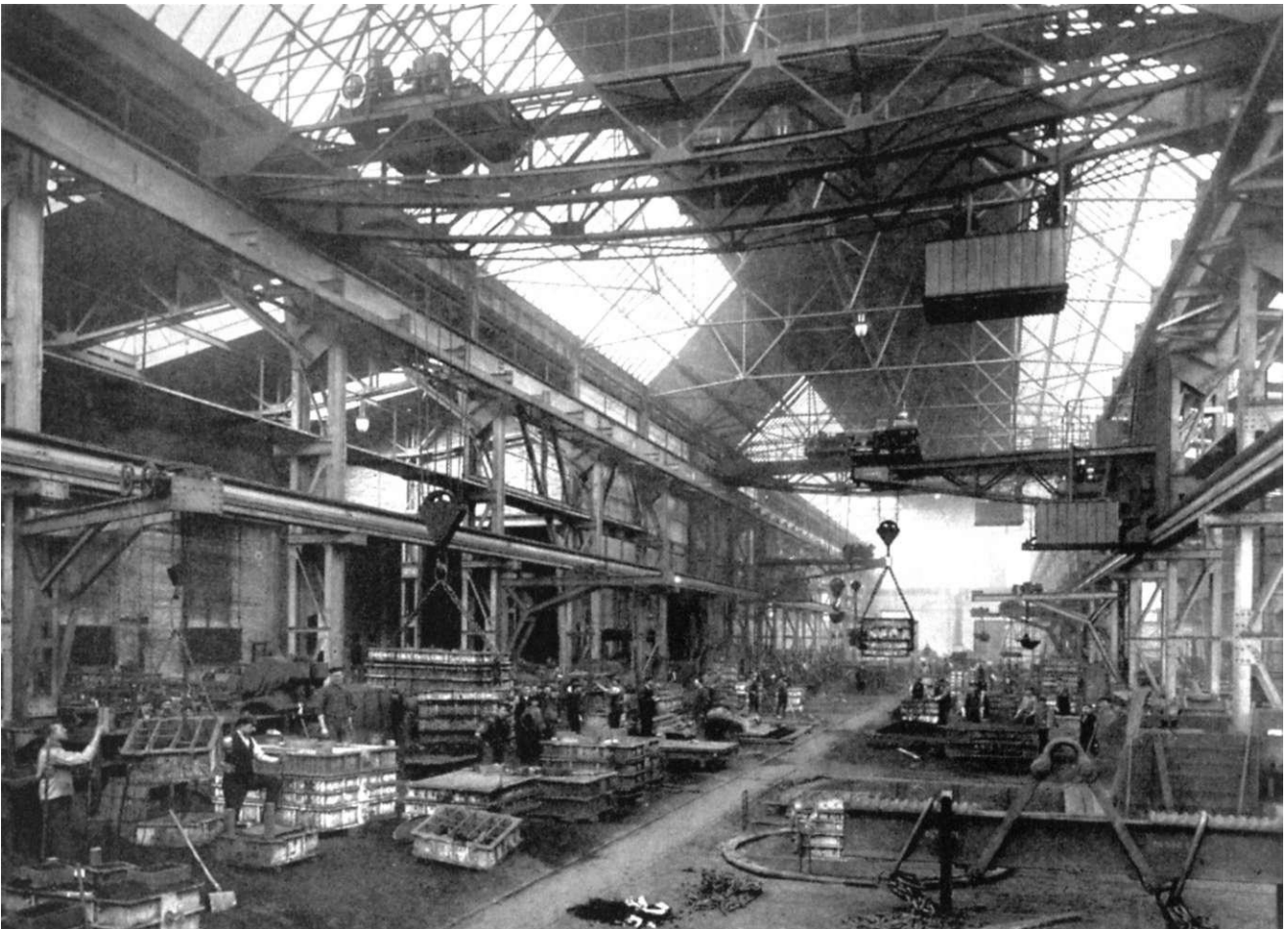
Abb. 58: Alt Salbke 6-10, Inneres der Gießereihalle 1912, Mittelhalle für schwere Gußstücke, Blick nach Norden
