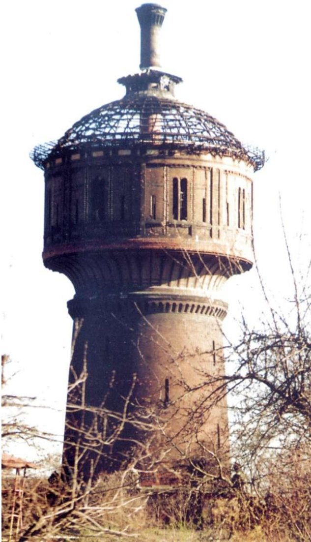
Abb. 67: Wasserturm des RAW Salbke
