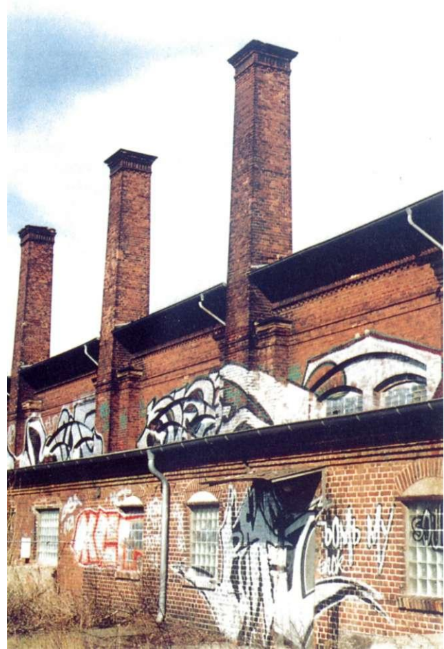
Abb. 87: Coquistastraße 16, Längsseite der Schmiede
