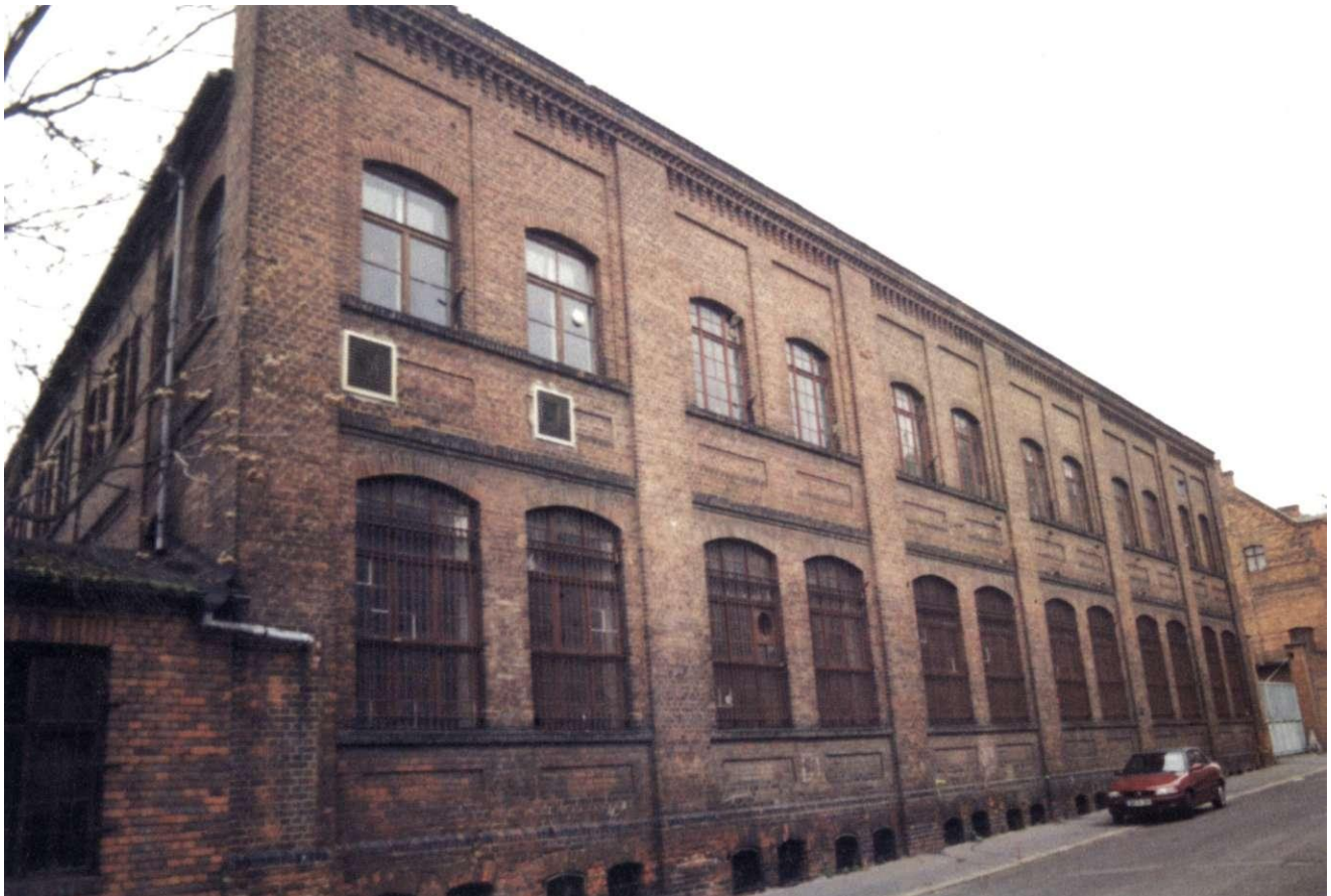
Abb. 110: Klosterbergstraße 7/11, Straßenfassade des Dreherei- und Schlossereigebäudes
