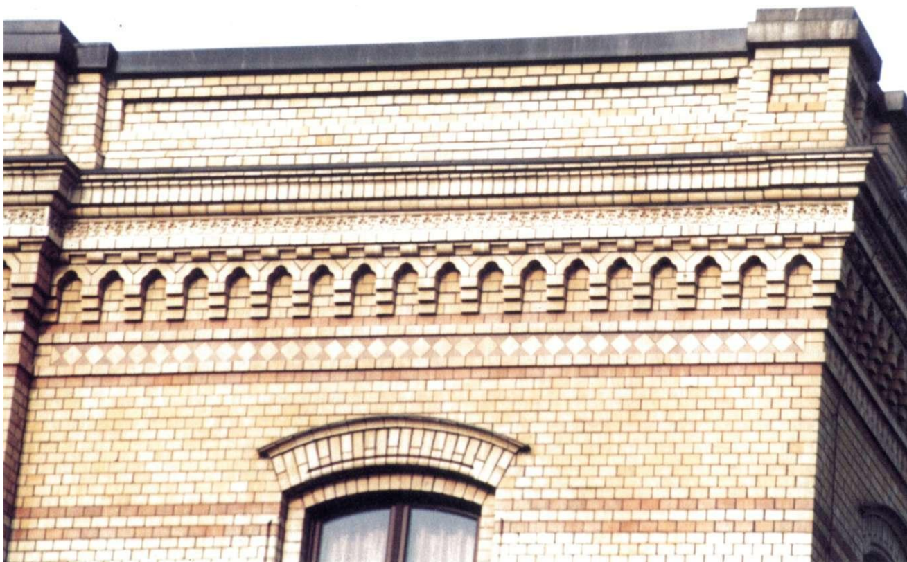
Abb. 104: Verwaltungsgebäude Karl-Schmidt-Straße 10, Detail Südseite
