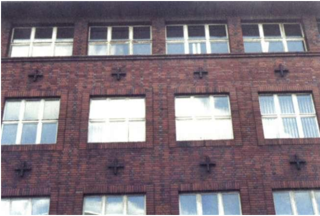
Abb. 132: Liebknechtstraße 65-91, Fabrik- und Wohlfahrtsgebäude I (Gebäude 45), Fassadendetail
