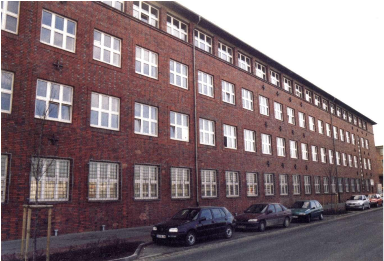
Abb. 133: Liebknechtstraße 65-91, Fabrik- und Wohlfahrtsgebäude II (Gebäude 102), Straßenfassade
