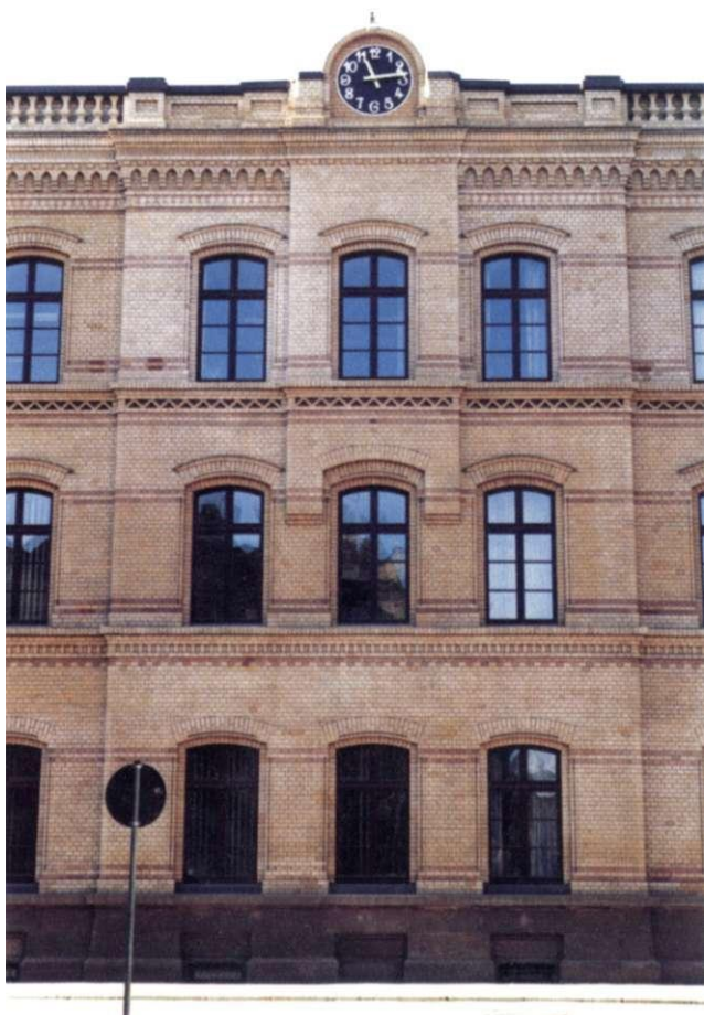
Abb. 103: Verwaltungsgebäude Karl-Schmidt-Straße 10, Mittelrisalit
