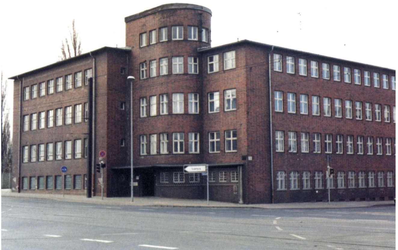
Abb. 129: Liebknechtstraße 65-91, Blick von der Straßenkreuzung auf das Bürogebäude (Gebäude 1)
