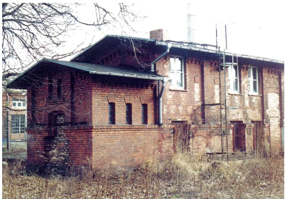
Abb. 86: Coquistraße 16, kleines Abortgebäude auf dem Gelände des RAW Buckau
