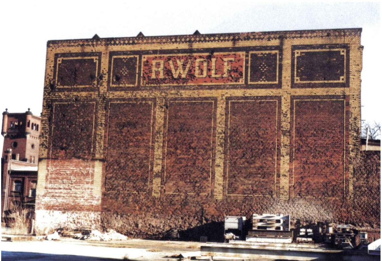
Abb. 109: Karl-Schmidt-Straße 9-12, fensterlose Rückseite der hydraulischen Nieterei
