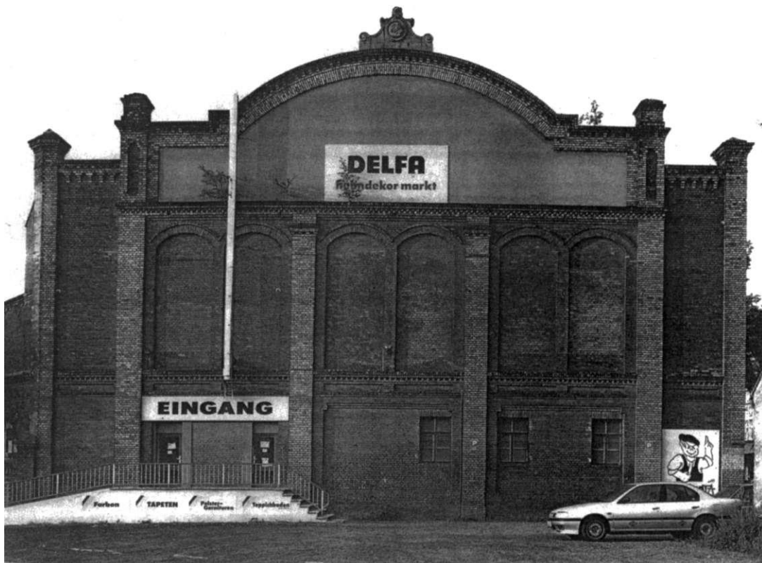
Abb. 94: Freie Straße 2-5, Blendfassade des einstigen Maschinenlagers
