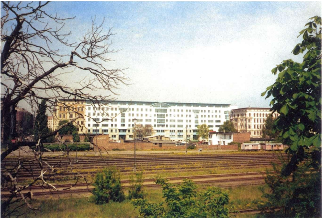
Blick über die Gleisanlagen auf die Bebauung an der Straße Schieinufer (Quartier 13)
