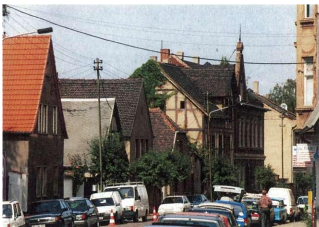
Die Simonstraße mit sehr unterschiedlicher Baustruktur und Gebäudetypen, z. T. Baudenkmale
