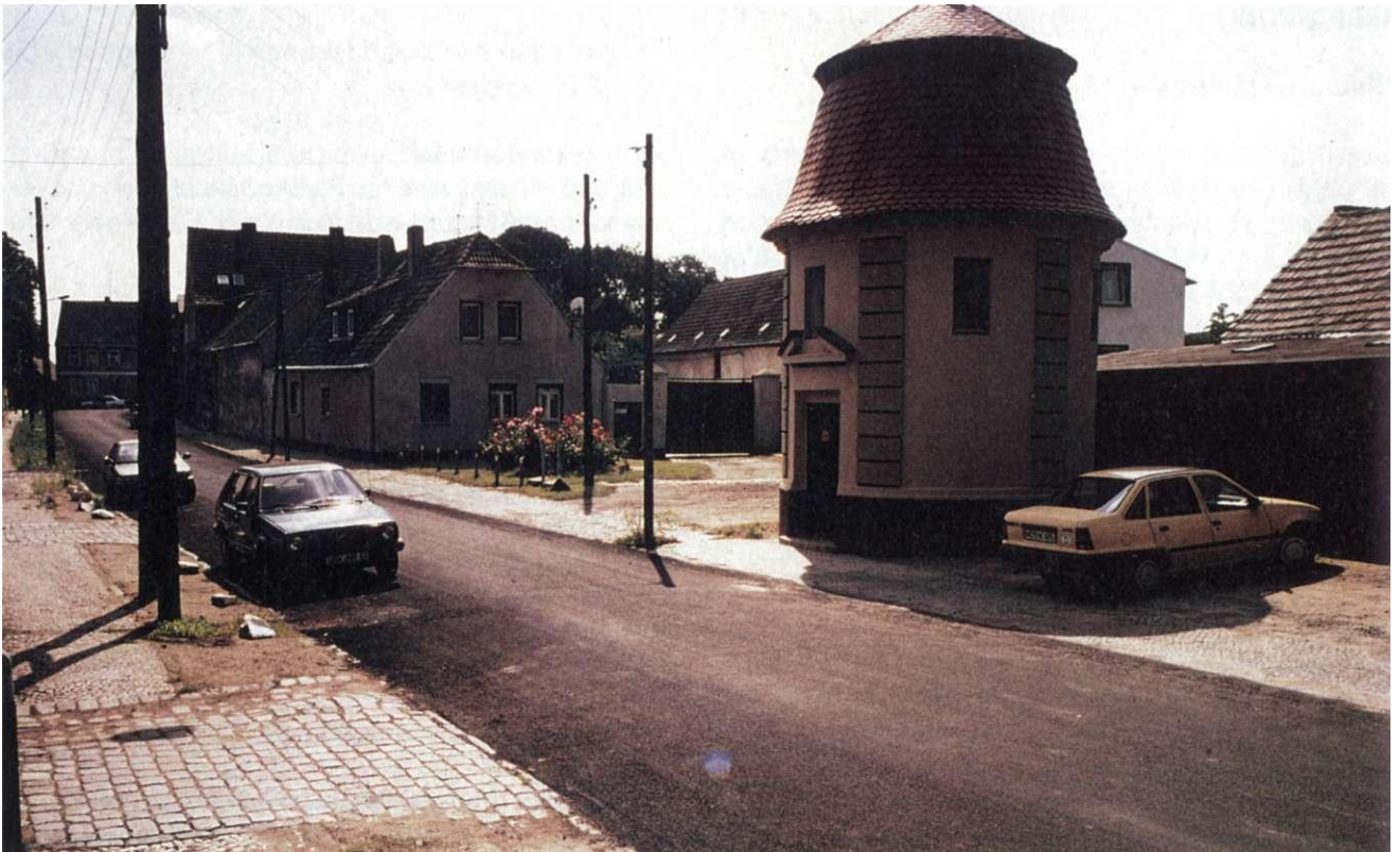
Das sanierte und wieder als Trafo-Station genutzte historische und denkmalwürdige Technikgebäude stellt einen positiven Blickfang im Verlauf des südlichen Straßenabschnittes "Alt-Prester" dar.
