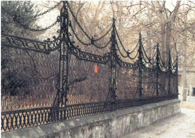
Abb. 96: Schmiedeeiserne Gittereinfriedung Kaiser-Otto-Ring 3, die einzelnen Felder sind mit Drahtgeflecht bespannt, welches zur Aufnahme der Ranken von wildem Wein oder sonstigen Rankenpflanzen dienen sollte
