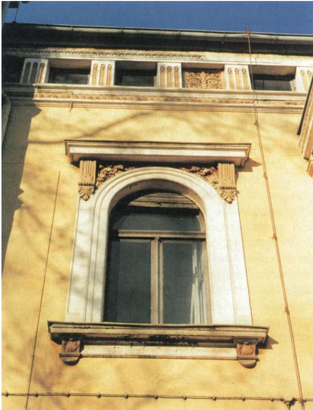
Abb. 71: Schönebecker Straße 11-13, Obergeschoßfenster und Teil des Metopen-Triglyphen-Frieses an der Gartenseite
