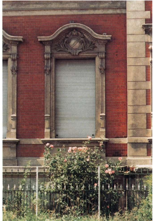
Abb. 92: Hannoversche Straße 7, Fenster in der Straßenfassade
