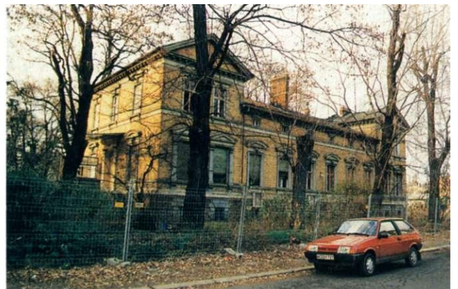
Abb. 64: Fabrikantenvilla Langer Weg 52
