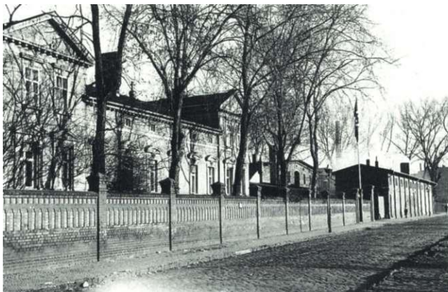
Abb. 63: Langer Weg 52, alte Aufnahme vom 8.6.1940
