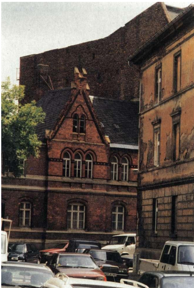
Abb. 74: Wohnhaus für die Bediensteten der Familie Wolf in der Braunschweiger Straße 6
