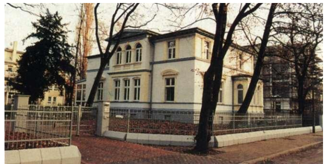
Abb. 56: Klausenerstraße 18, Blick von Norden, am Risalit; im Erdgeschoß der erst 1908 geschlossene ehemalige Wintergarten
