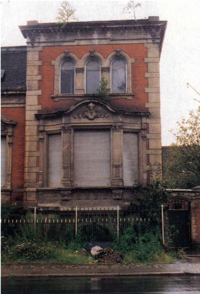
Abb. 91: Hannoversche Straße 7, Risalit an der Straßenfassade
