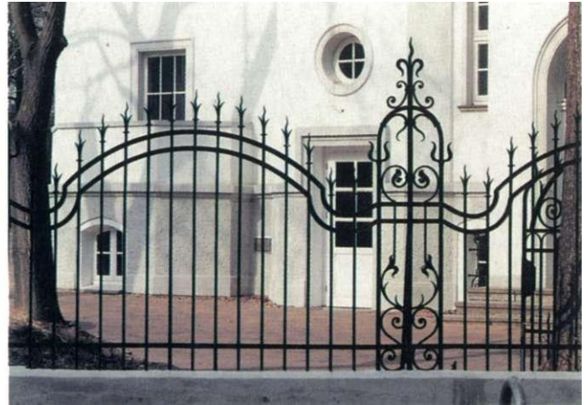
Abb. 97: Eisengittereinfriedung Richard-Wagner-Straße 4 a
