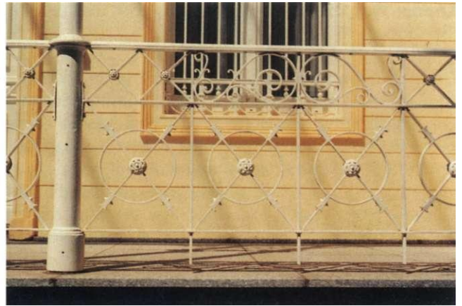
Abb. 55: Klausenerstraße 18, im klassizistischen Stil gehaltenes Geländer der schmiedeeisernen Überdachung vor dem Eingang
