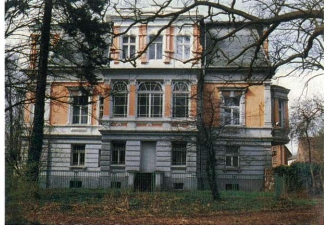
Abb. 85: Lüttgen Ottersleben 19, linke Seitenfassade
