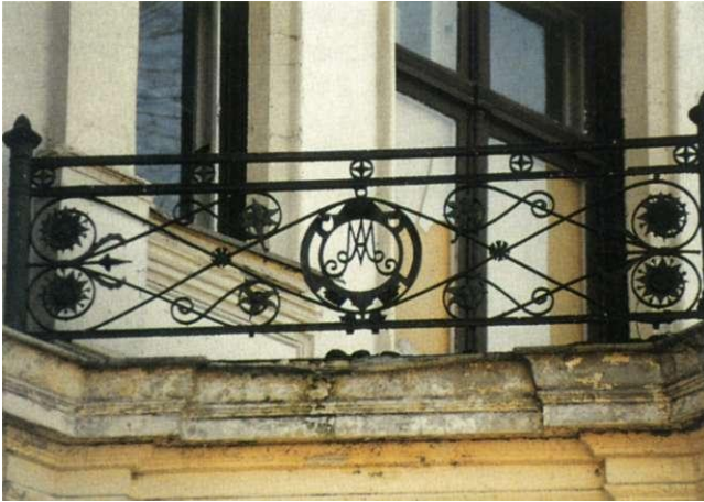
Abb. 49: Zollstraße 16, Detail am Balkongitter der Straßenfront mit den Initialen AM
