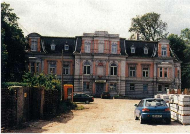
Abb. 84: Lüttgen Ottersleben 19, Hoffassade
