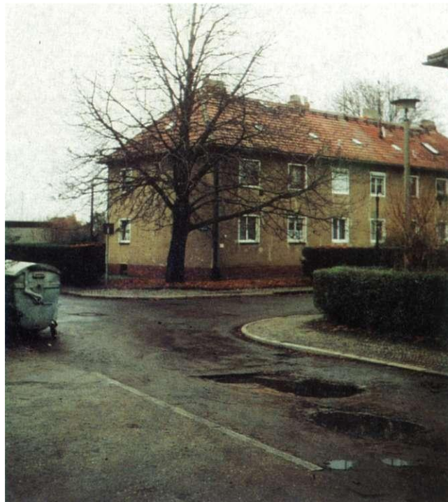
Abb. 36: Treseburger Straße, Kreuzungsbereich
