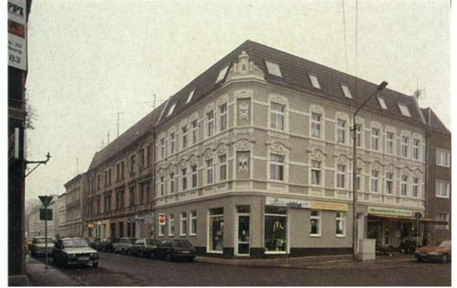
Abb. 32 a: Blankenburger Straße 1, 1908, Bauherr A. Kaiser
