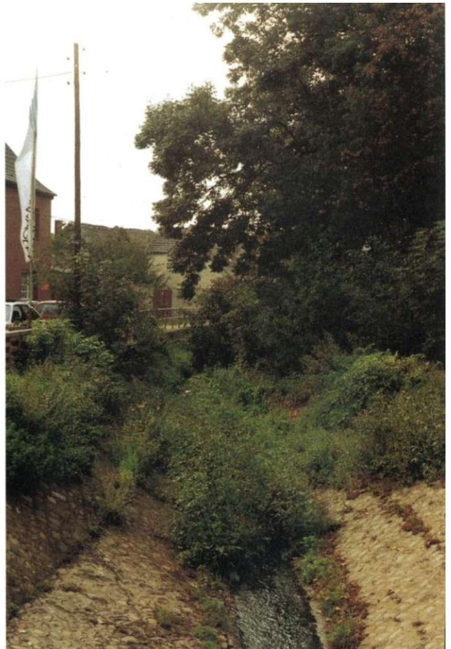
Abb. 46: Ausgebauter Gewässerlauf Hemsdorfer Straße
