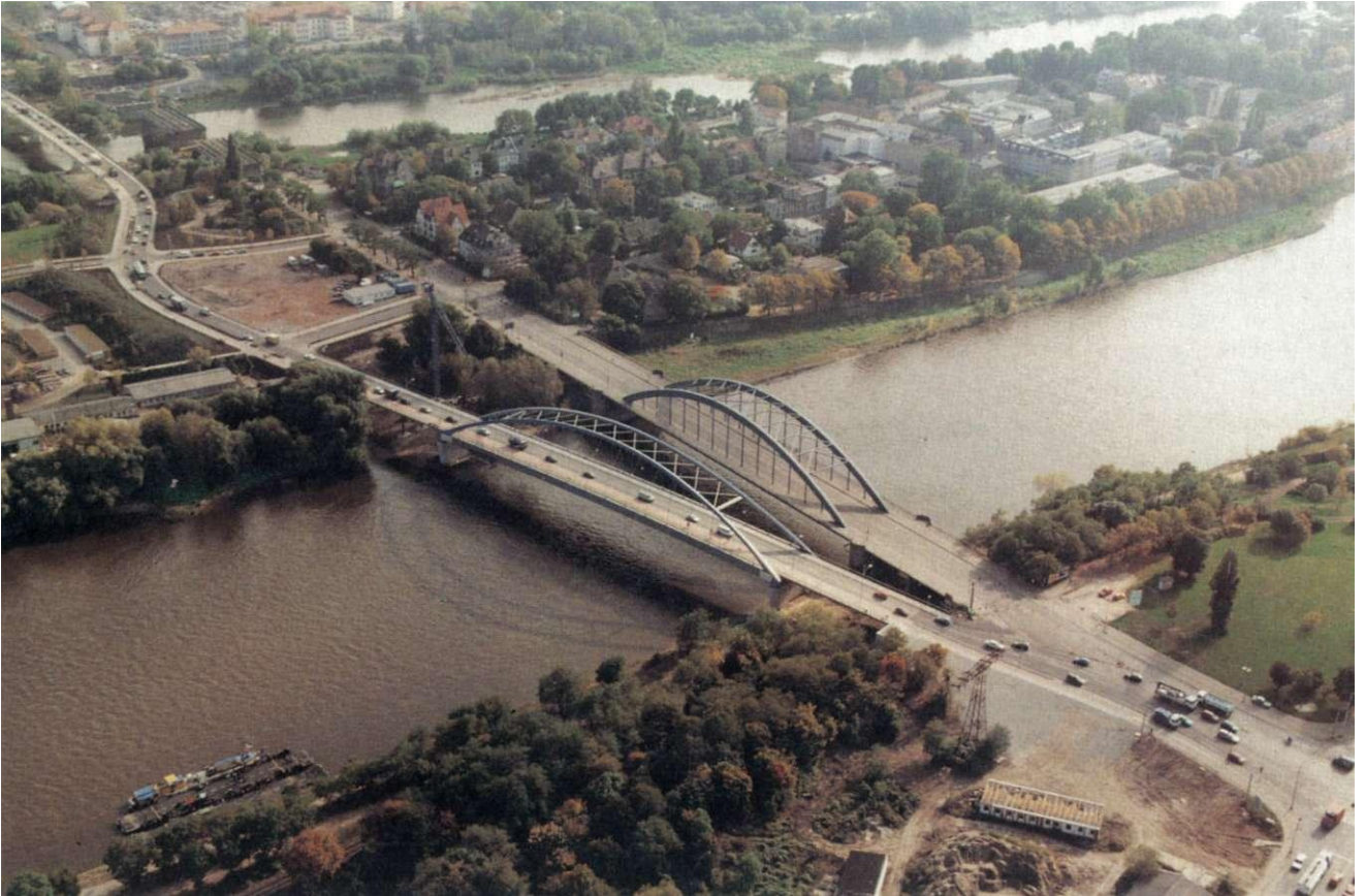
Vierspuriger Ausbau des Nordbrückenzuges kurz vor der Fertigstellung
