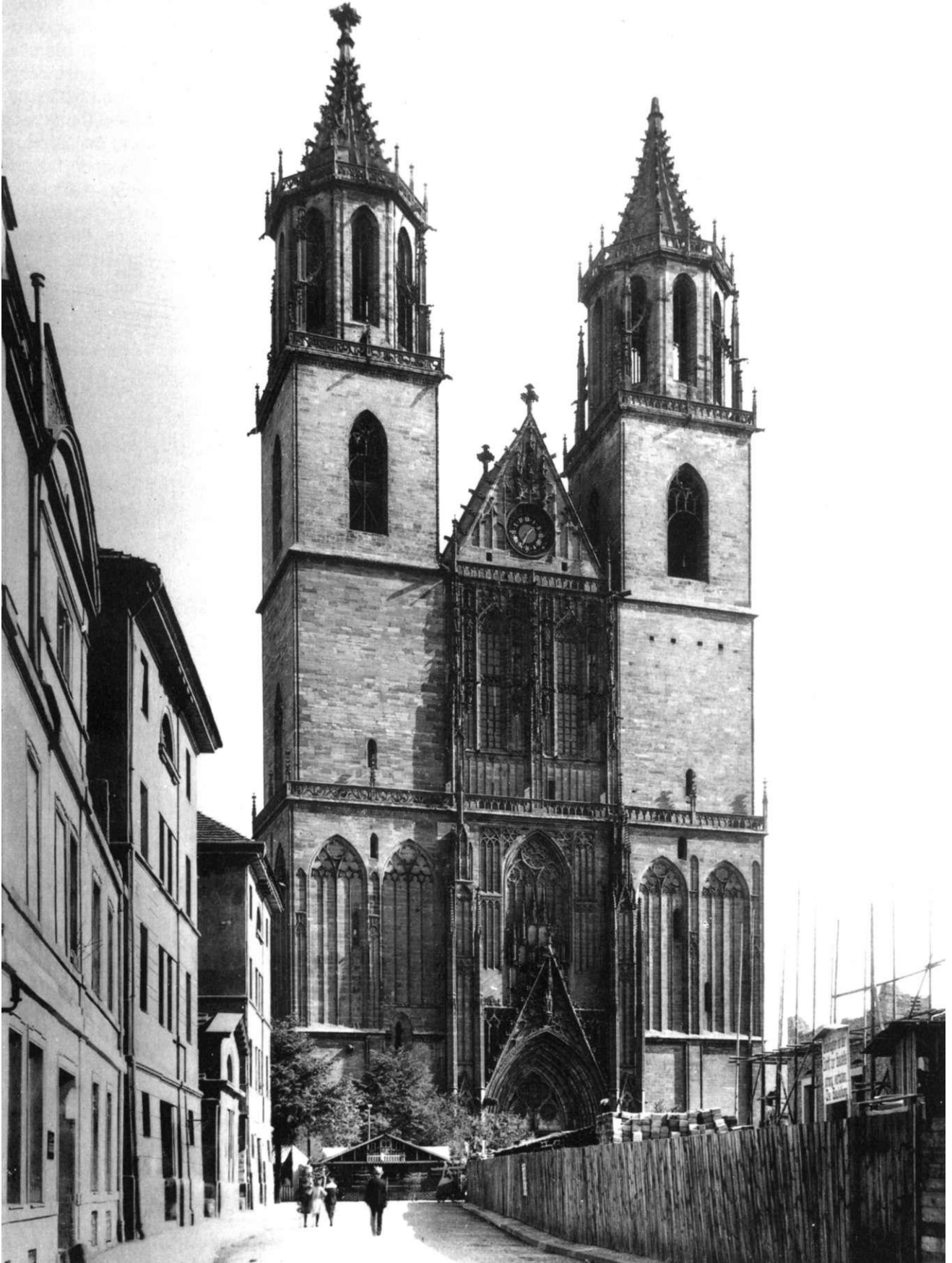
1921, das Reichsbankgebäude Domstraße 1 im Bau, links die Stirnseiten der alten Trainkaseme, im Hintergrund die Buden der Herbstmesse
