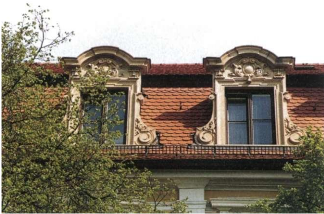
Domplatz 8, Detail Dachfenster
