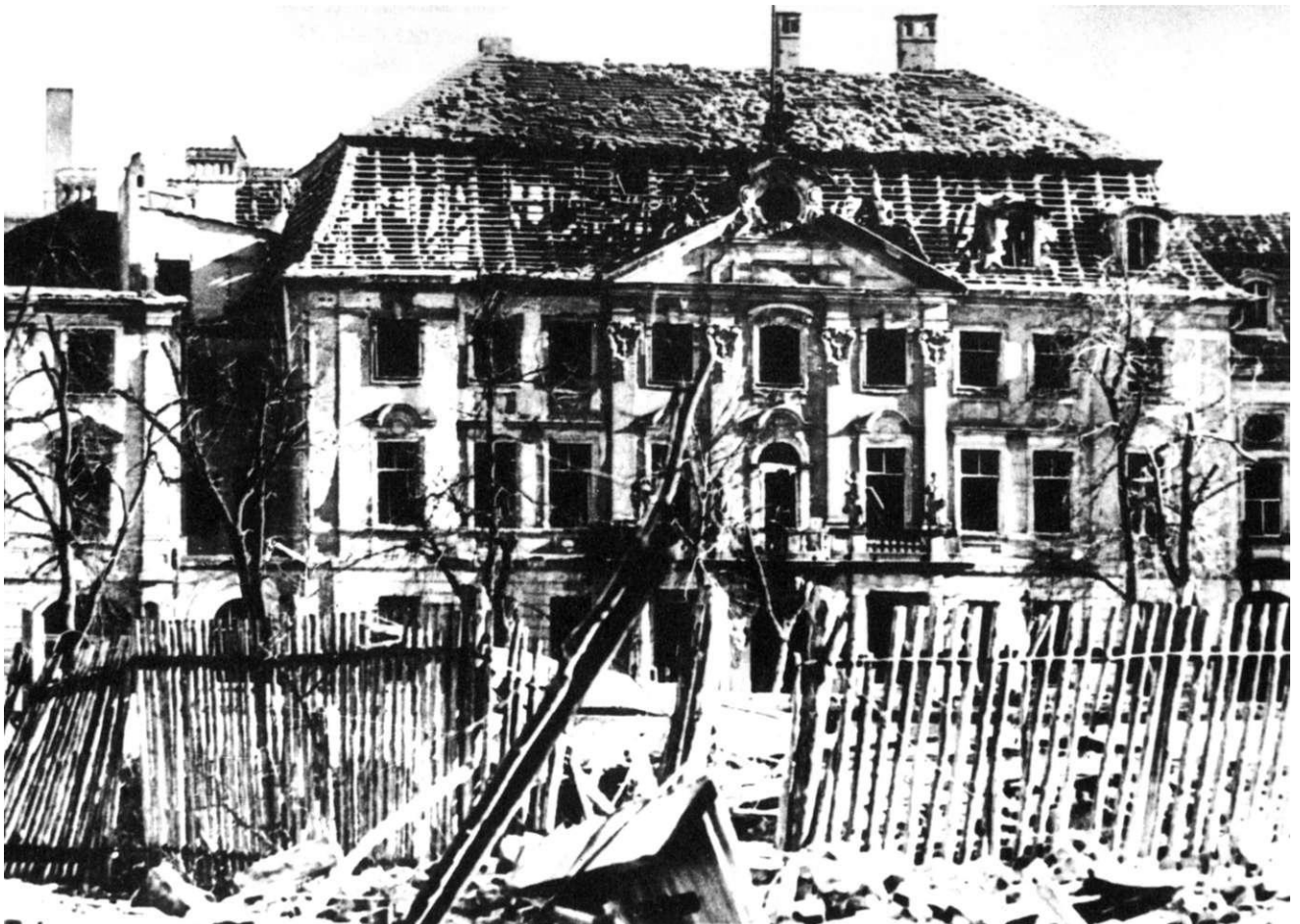
Domplatz 4 mit Kriegsschäden
