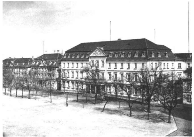
Domplatz Westseite mit Nr. 2/3, Zustand mit 2. Obergeschoss, Aufnahme vor dem 2. Weltkrieg
