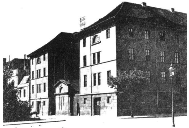
Südöstliche Ansicht der Trainkaserne am Domplatz, Aufnahme vor dem Baubeginn des Reichsbankgebäudes
