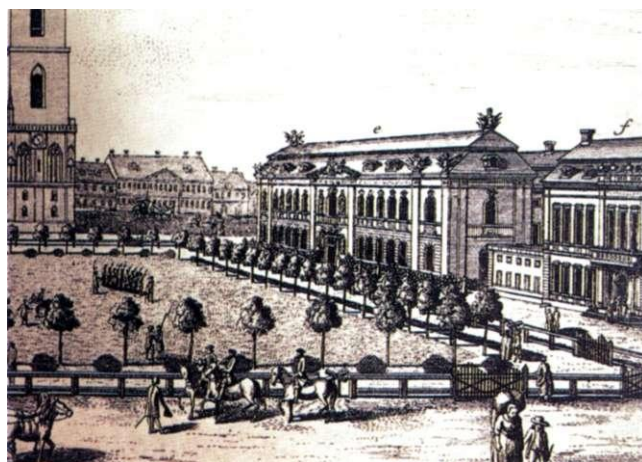
Zeughaus Domplatz 11, angeschnitten Dompropstei Domplatz 10, Ausschnitt aus dem Kupferstich um 1765
